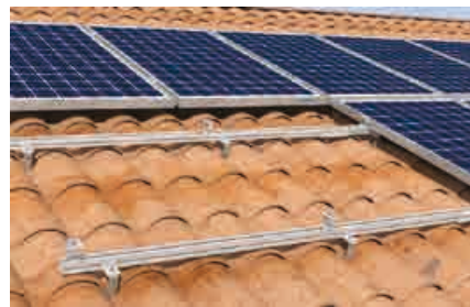
Detalle: Posicionamiento de las abrazaderas
