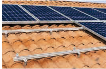
Cubierta coplanar con teja
