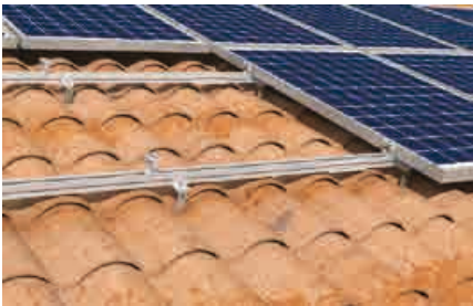
Detalle: Posicionamiento de las abrazaderas
