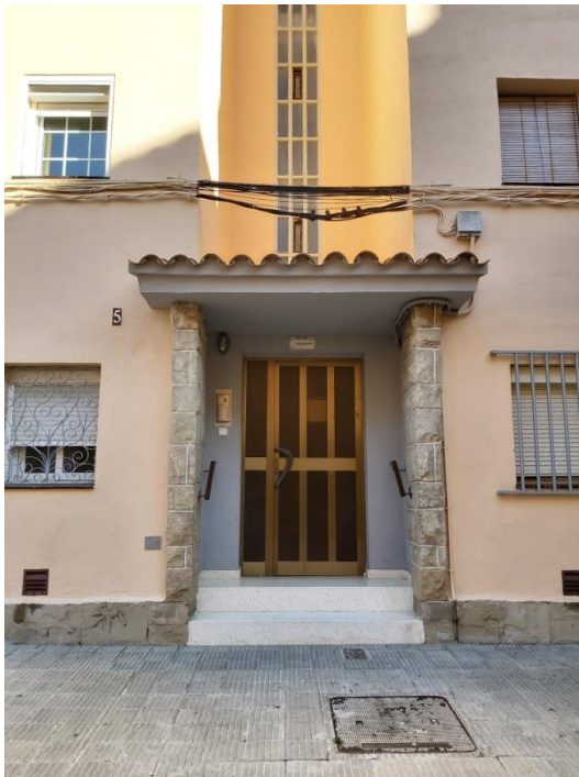
Accés a l'edifici
