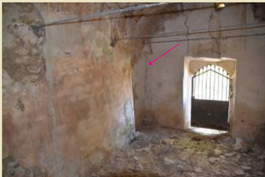
Fig. 32. Vista de l'entrada a l'ermita amb indicació de la situació de la fornícula. (Secció d'Arqueologia).
