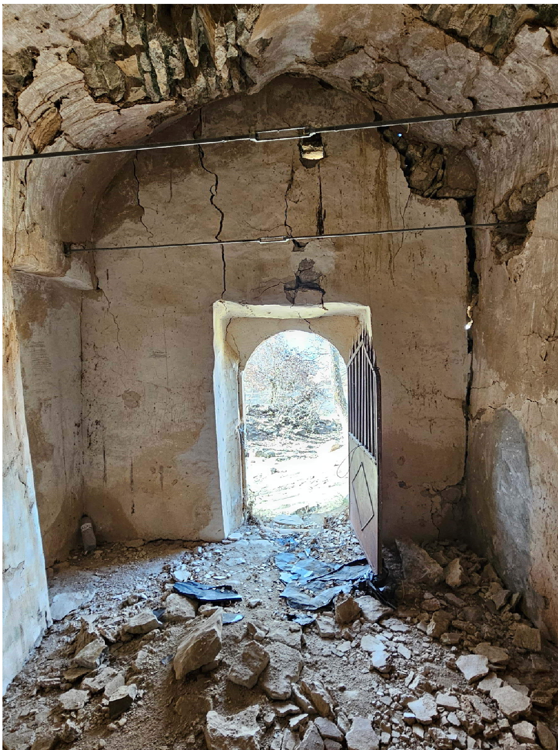
Interior de la capella de Sant Fruitós d'Aransís amb els tirants col·locats l'any 2020 i la runa interior (Fotografia del 29 de gener de 2024)
