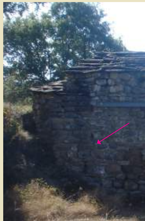
Fig. 15. Vistes de la façana nord amb indicació del reforç. Dalt, l'any 2008 (Gustau Erill i Pinyot, Wikipedia) al mig l'any 2010 des de la capçalera i a sota, l'any 2011 amb la biga col·locada pels tensors interiors (Fotos dels Amics d'Aransis). A l'ampliació de la foto de l'any 2011 podem veure indicada la línia de contacte entre la façana i el reforç, i com aquest queda encastat per donar-li força a la cantonada. Es veu clarament que és una intervenció antiga.
