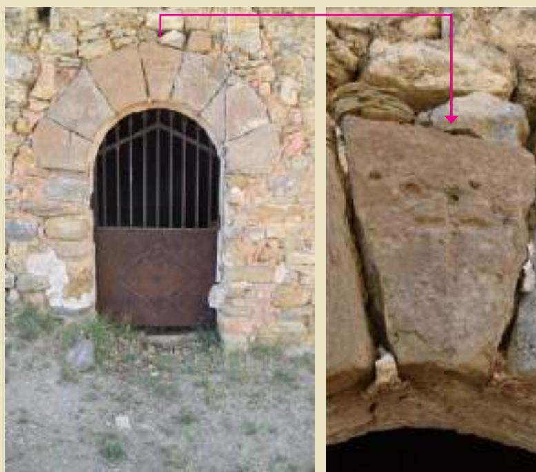
Fig. 20. Imatge de la porta amb l'arc dovellat amb detall de la seva clau de volta gravada amb una creu. Podem observar com l'arc és un element afegit amb posterioritat. (Foto Secció d'Arqueologia)
