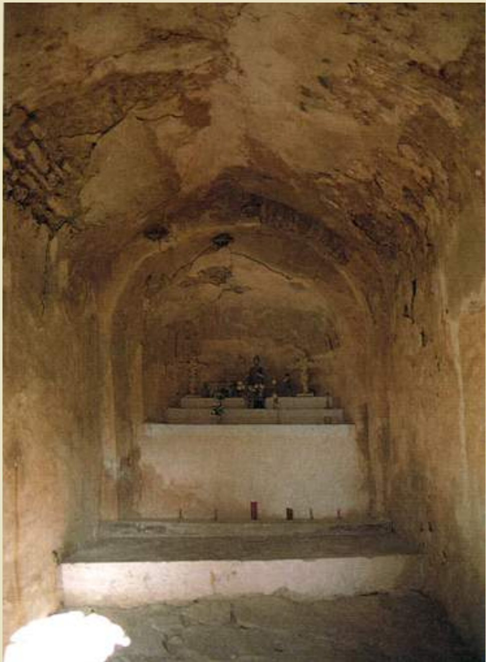
Fig. 27. Imatge de la Catalunya Romànica del presbiteri, amb el terra de lloses i els graons que eleven aquest espai de l'ermita de la resta de la nau. (Foto ECSA - J. A. Adell)
