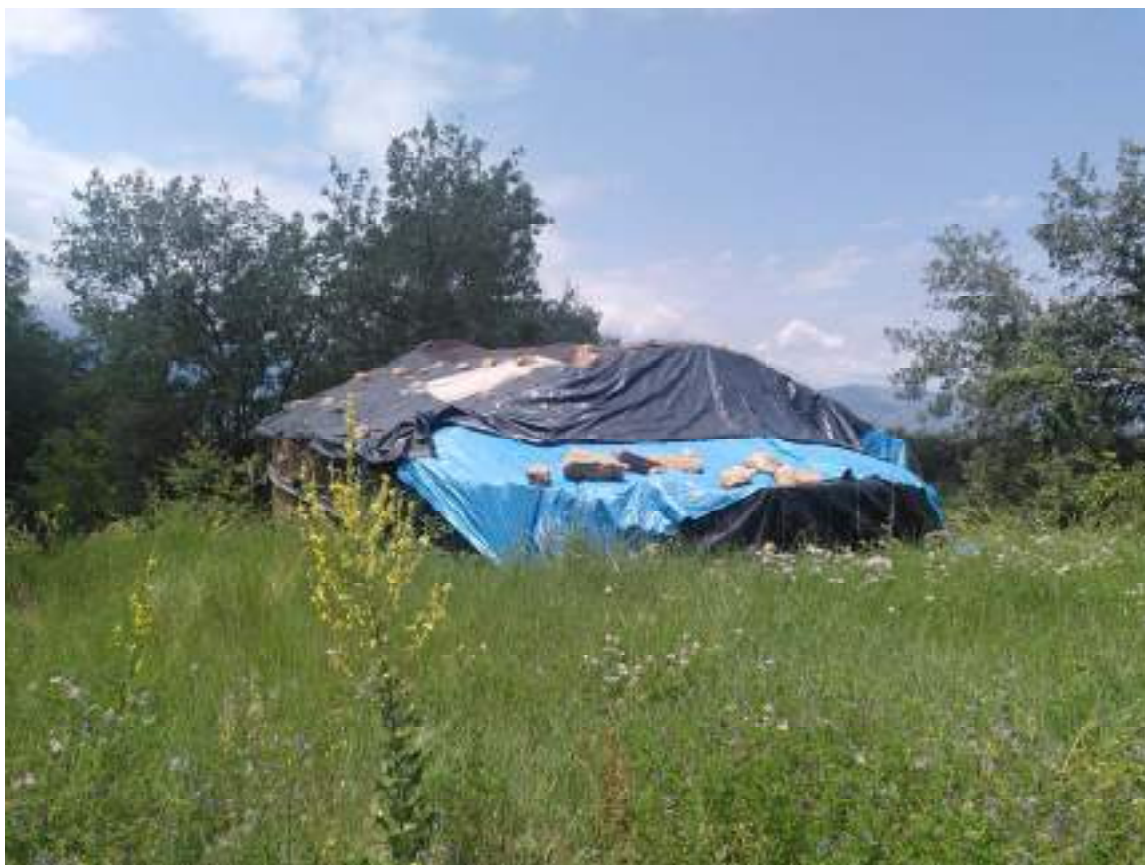
Proteccions provisionals de la coberta de l'ermita des de la façana nord (Fotografia del 4 de juliol de 2023)
