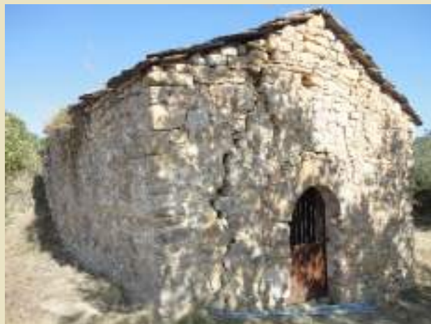
Fig. 18. Detall de les esquerdes de la façana principal de l'ermita, dalt l'any 2011, tot just abans de col·locar els tensor interiors, i a sota a l'abril del 2021. Es pot apreciar la gravetat estructural que han provocat i el desplom dels murs. (Amics d'Aranis i Secció d'Arqueologia de la Diputació de Lleida).
