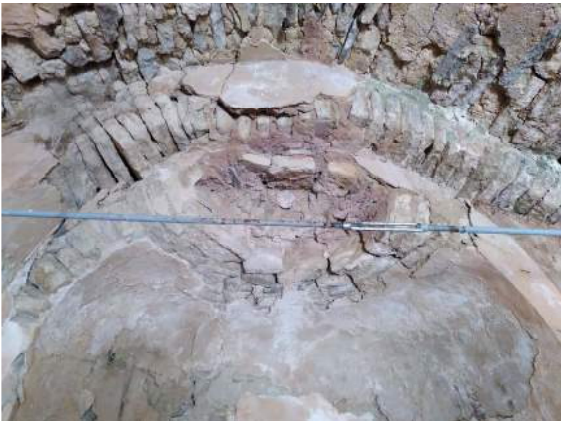
Cúpula de l'absis deformat i parcialment col·lapsat de Sant Fruitós d'Aransís (Fotografia del 4 de juliol de 2023)
