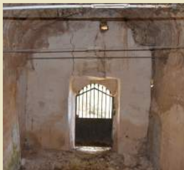
Fig. 19. Detall de la façana principal des de l'interior, amb detall de l'esquerda que deixa passar la llum i afecta l'estabilitat del mur (Secció d'Arqueologia).
