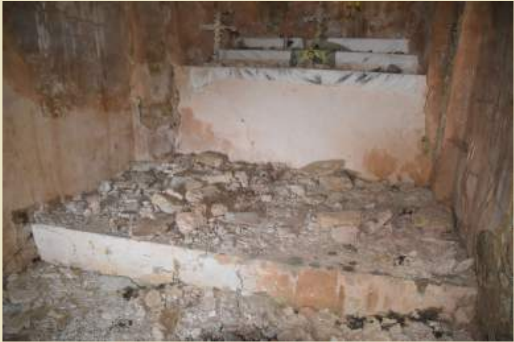
Fig. 28. Detall del graó esbiaixat, cobert per la runa (Secció d'Arqueologia).
