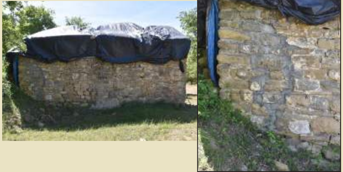
Fig. 16. Situació i detall de la cantonada nord-est amb el rejuntat del punt de contacte entre el mur i el reforç. (Secció d'Arqueologia)
