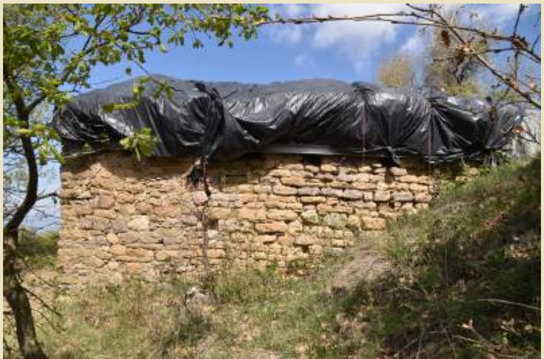
Figura 11. Detalls del parament dels murs nord i sud, on s'aprecien les filades i els petits carreus treballats. (Secció d'Arqueologia).
