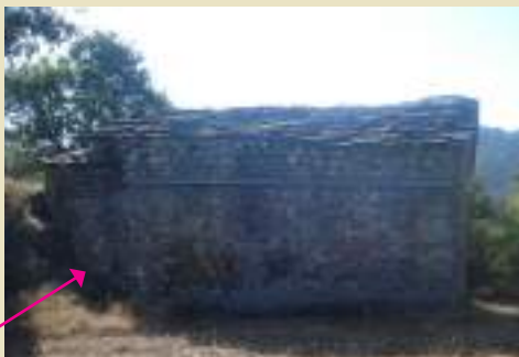
Fig. 15. Vistes de la façana nord amb indicació del reforç. Dalt, l'any 2008 (Gustau Erill i Pinyot, Wikipedia) al mig l'any 2010 des de la capçalera i a sota, l'any 2011 amb la biga col·locada pels tensors interiors (Fotos dels Amics d'Aransis). A l'ampliació de la foto de l'any 2011 podem veure indicada la línia de contacte entre la façana i el reforç, i com aquest queda encastat per donar-li força a la cantonada. Es veu clarament que és una intervenció antiga.
