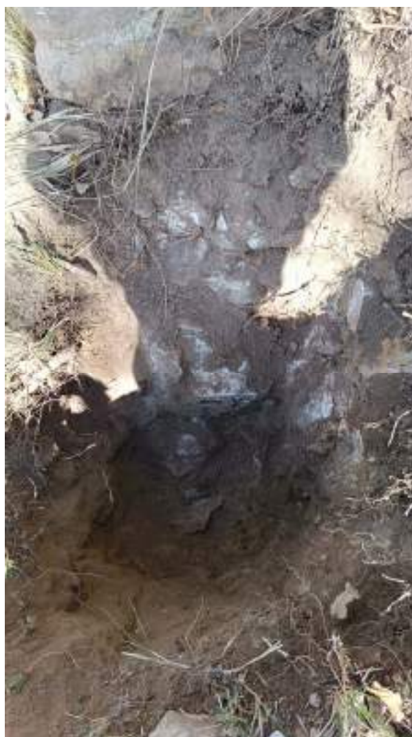
Cala 1 de la fonamentació en la façana oest (Fotografia del 7 de febrer de 2024)
