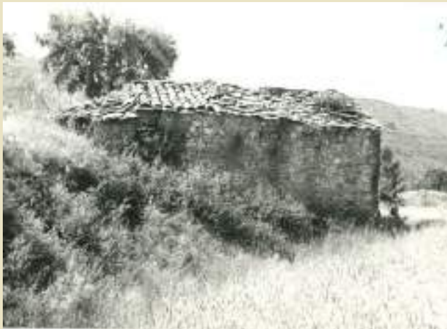
Figura 6. Magnífiques fotos de Jordi Mir de l'any 1965 on podem apreciar l'estat de conservació de l'ermita, amb les esquerdes del mur frontal, i una reparació de la teulada, amb afegiment de teules per sobre de les lloses de pedra just davant de l'absis. Jordi Mir 1965.
