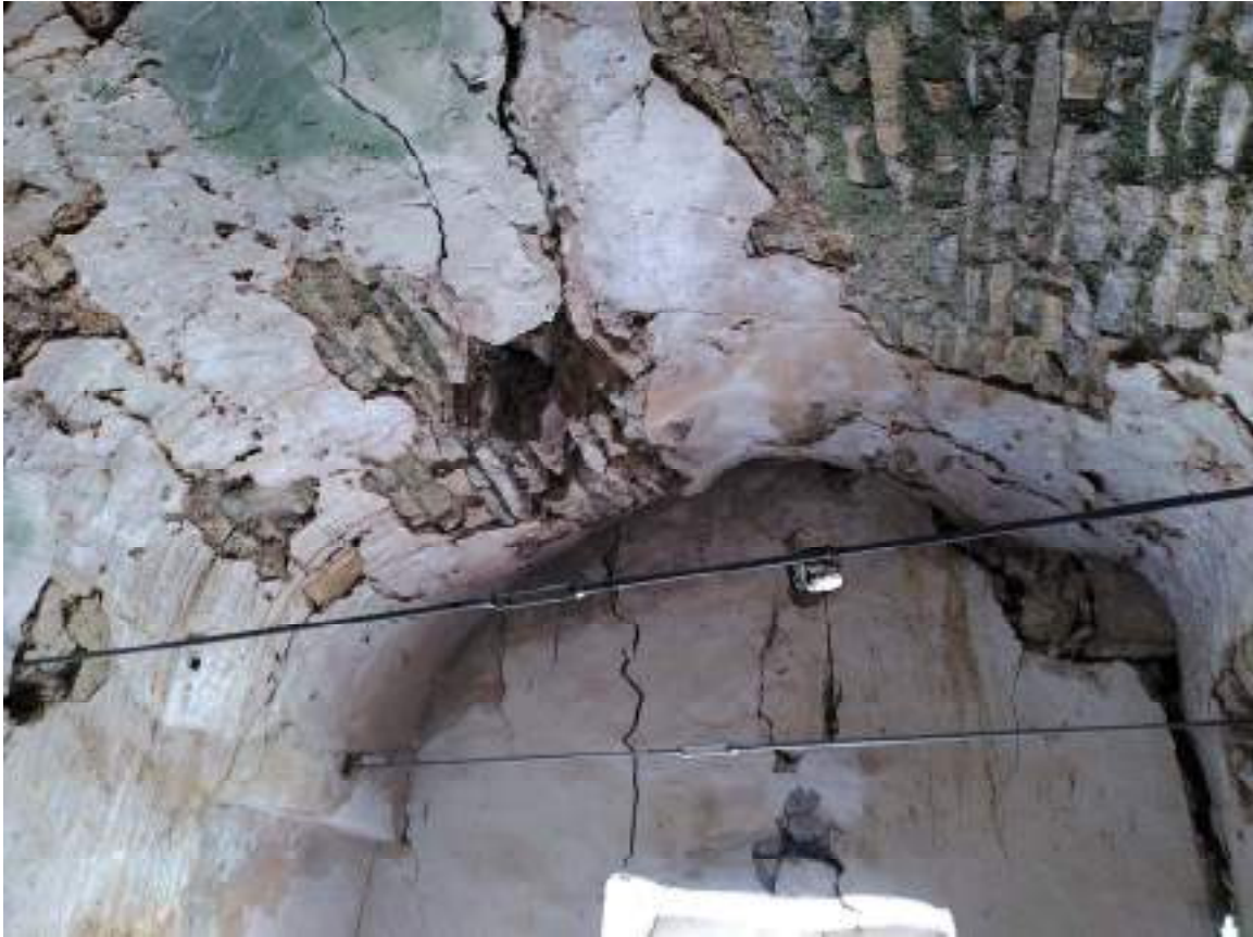
Volta de la nau deformada i parcialment col·lapsada de Sant Fruitós d'Aransís (Fotografia del 4 de juliol de 2023)
