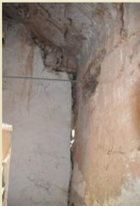
Fig. 19. Detall de la façana principal des de l'interior, amb detall de l'esquerda que deixa passar la llum i afecta l'estabilitat del mur (Secció d'Arqueologia).
