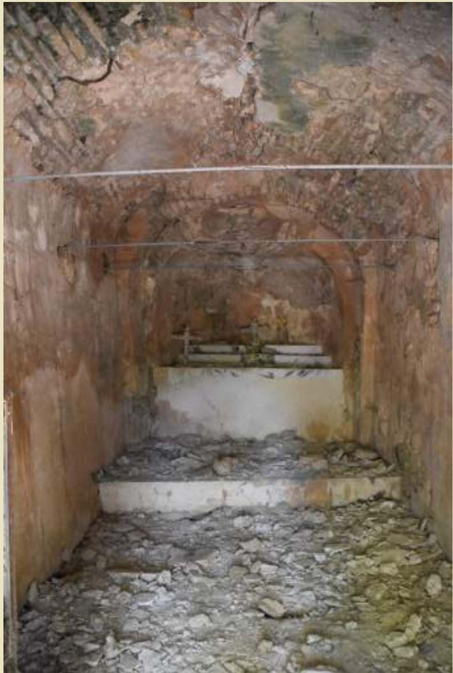
Fig. 23. Imatge de l'interior de l'ermita, amb els tensors, i el terra cobert de fragments de guixos de l'intradós. (Secció d'Arqueologia).
