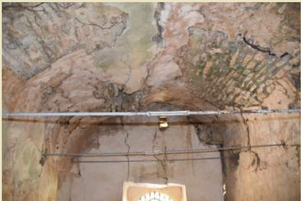
Fig. 25. Dues imatges de l'intradós de la coberta. Dalt, des de la porta, i a sota des del presbiteri, amb l'arrebossat caigut i amb les pedres a la vista. (Secció d'Arqueologia)
