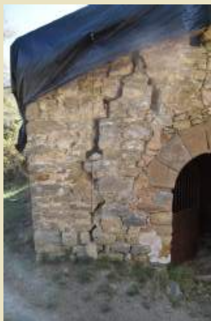
Fig. 18. Detall de les esquerdes de la façana principal de l'ermita, dalt l'any 2011, tot just abans de col·locar els tensor interiors, i a sota a l'abril del 2021. Es pot apreciar la gravetat estructural que han provocat i el desplom dels murs. (Amics d'Aranis i Secció d'Arqueologia de la Diputació de Lleida).
