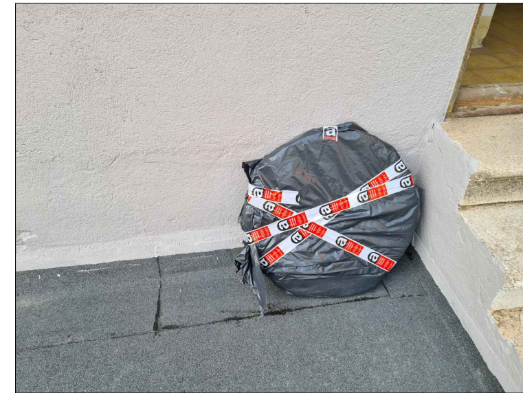
MATERIAL LOCALITZAT AMB CONTINGUT DE MCA PRECINTAT A L'ESPERA DE SER RETIRAT
