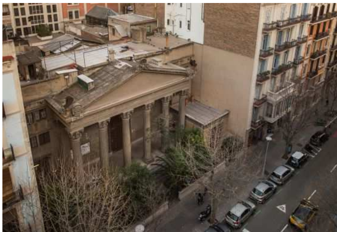
Edifici Taller Mas Riera del Districte de l'Eixample
