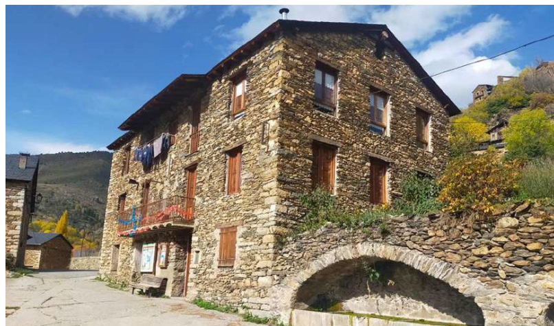
Edifici on es realitza l'actuació en planta primera
