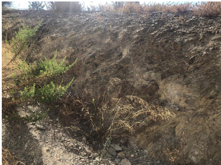
FOTOGRAFIA 14. Estació Geomecànica EG-01. Emplaçament
