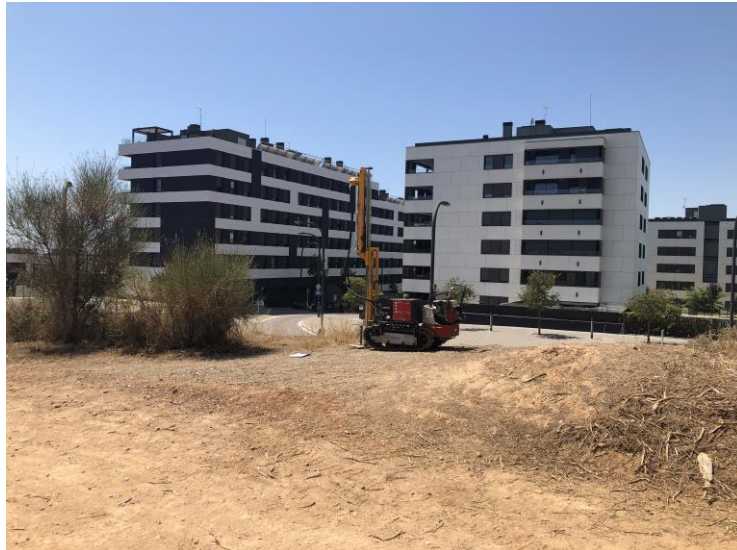
FOTOGRAFIA 10. Penetròmetre P-01. Emplaçament
