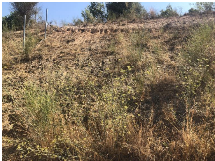
FOTOGRAFIA 12. Sèrie SE-01. Emplaçament
