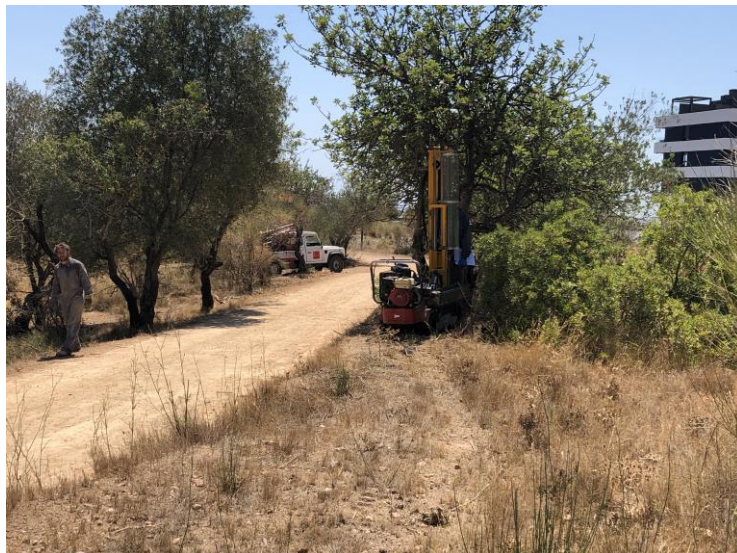
FOTOGRAFIA 11. Penetròmetre P-02. Emplaçament
