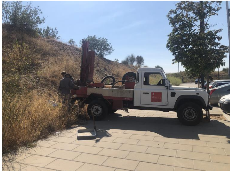
FOTOGRAFIA 1. Sondatge S-01. Emplaçament
