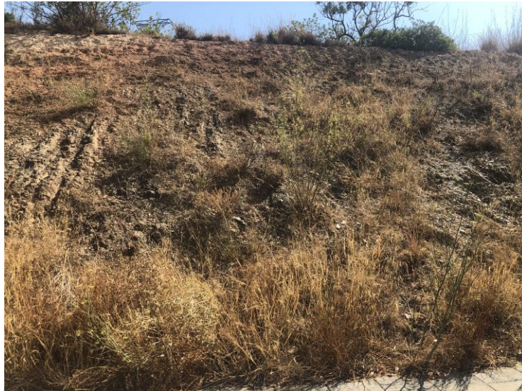
FOTOGRAFIA 13. Sèrie SE-02. Emplaçament
