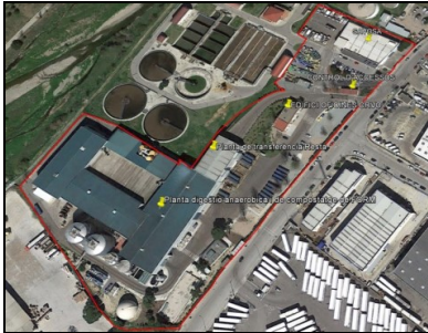
Figura 1. Vista aèria del CCTRVO. Font: Google Maps 2019.
