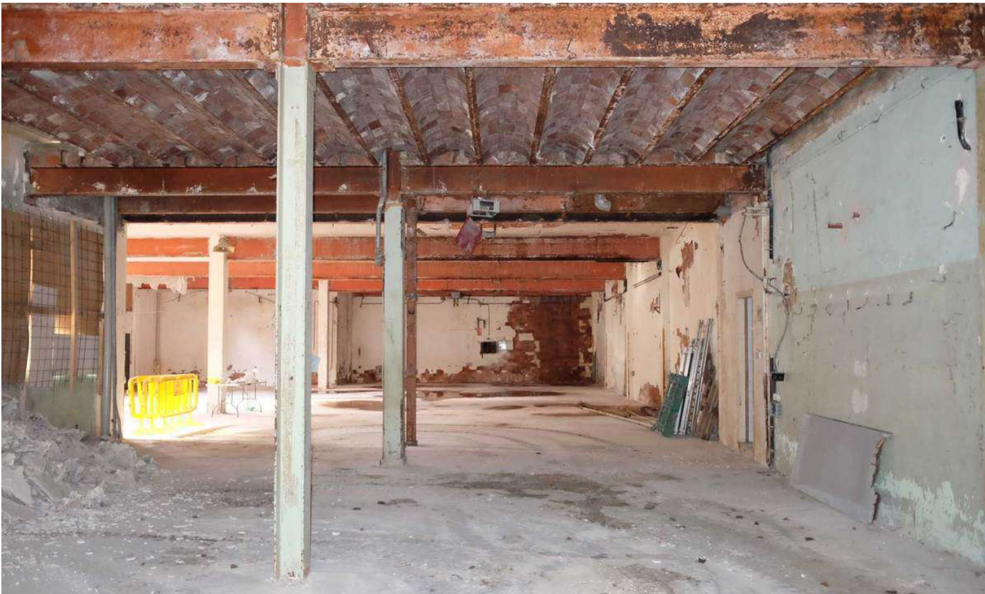
Estructura de bigues, jàsseres i pilars metàl·lics nivell 0, zona més antiga (davant). Bigues ceràmiques, jàsseres metàl·liques i pilars de formigó a la zona més nova (al fons).
