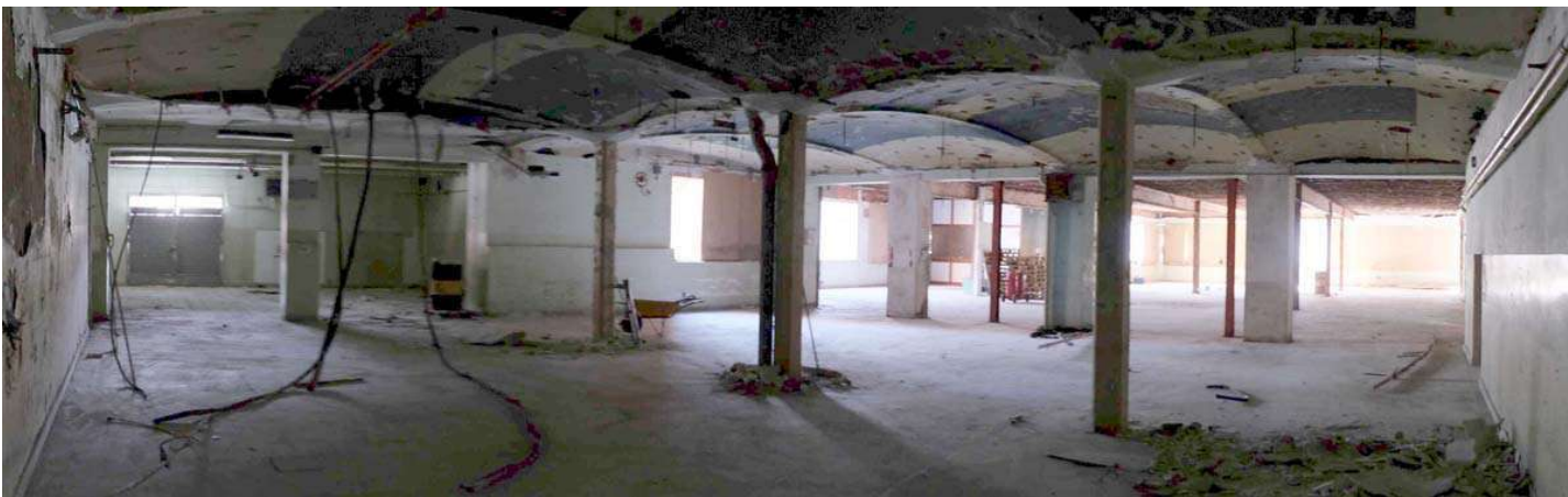
Estructura de voltes i pilars a la planta nivell 1, zona més antiga.
