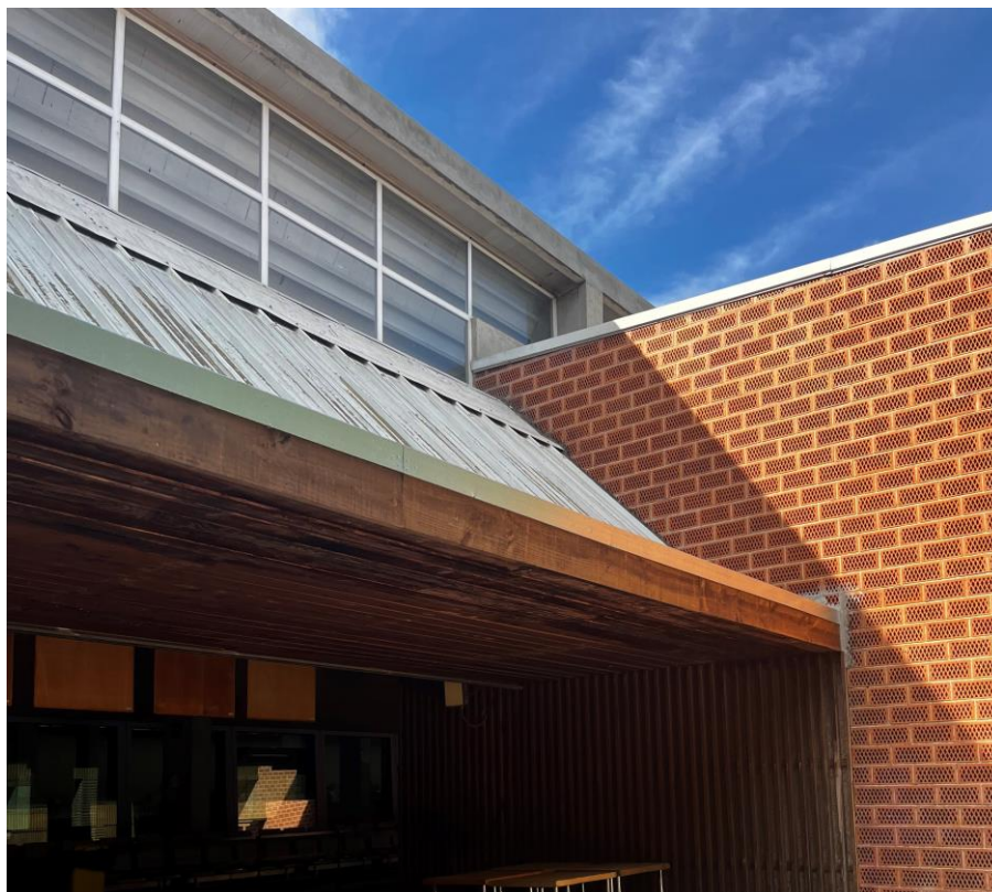
Galeria de 25m
