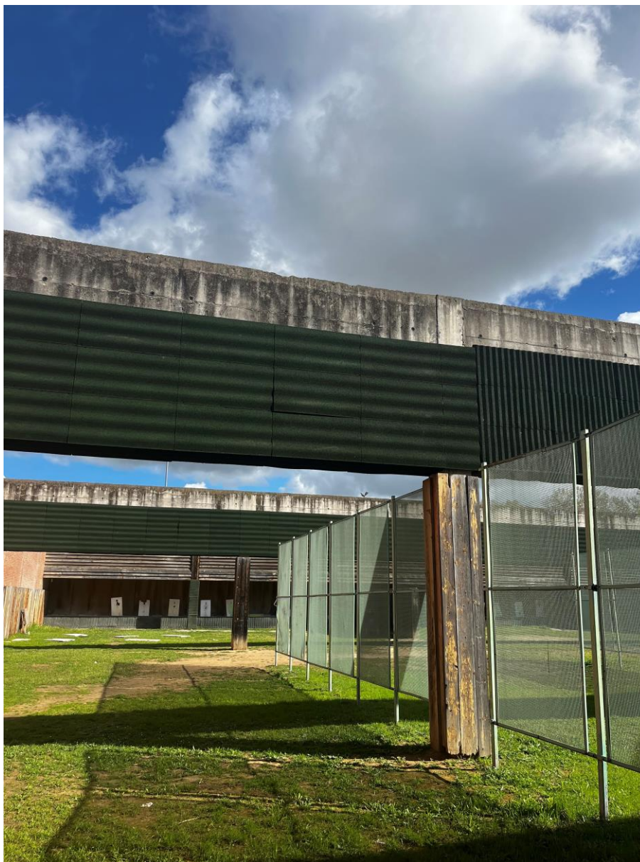
Galeria de 50m
