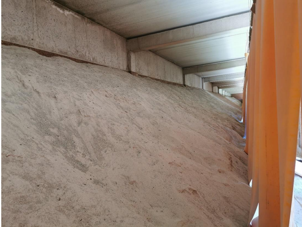
Galeria de 50m
