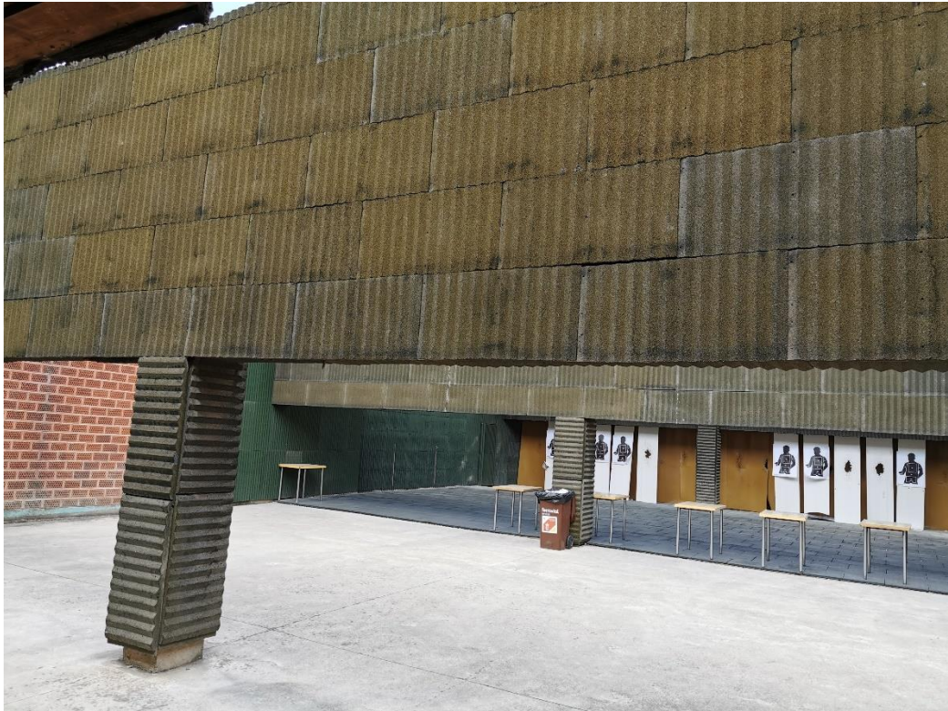
Galeria de 25m
