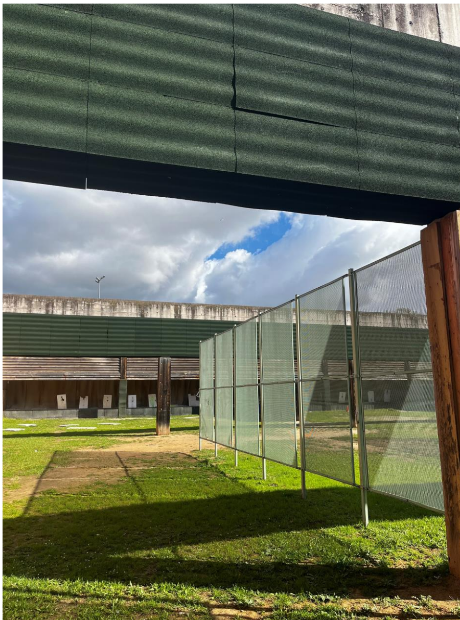
Galeria de 50m
