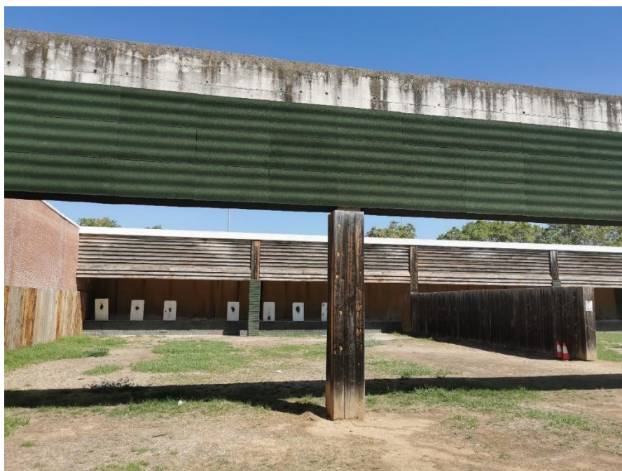
Galeria de 50m
