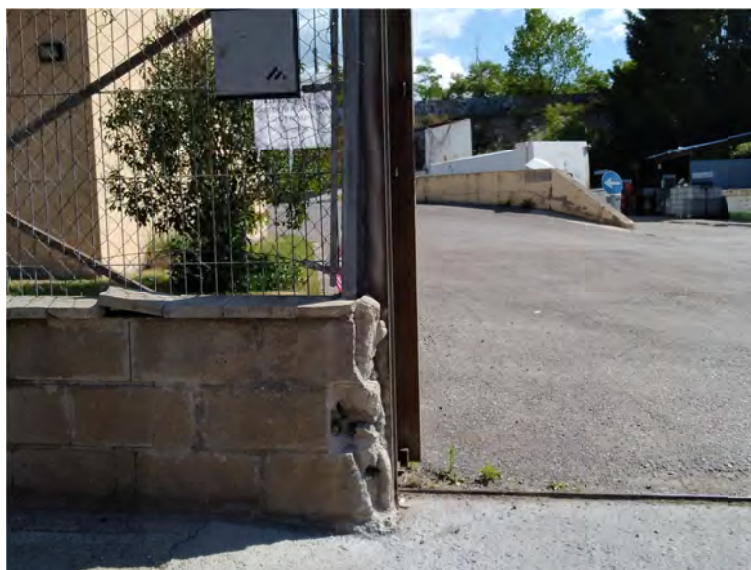
Fotografia 5. Mur i tanca exterior existent
