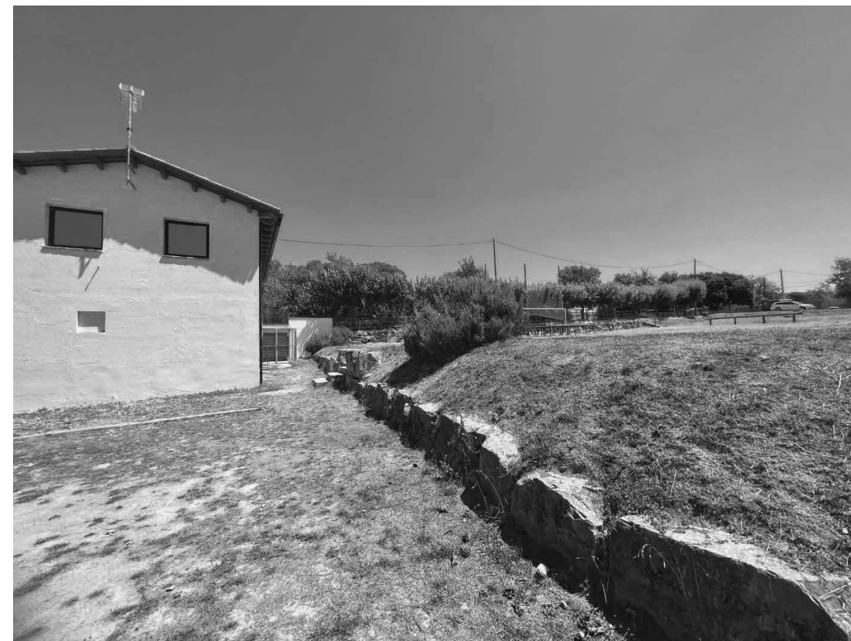
Imatge del mur de rocalla nord-oest, les escales i l'edificació.
