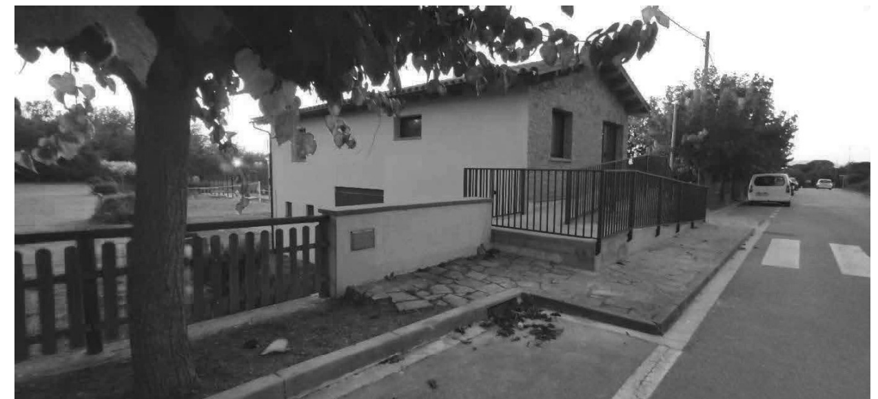
Imatge des de la cota de l'avinguda on es veu l'edificació existent amb les dues rampes i l'escala d'accés, un tram de la vorera existent, el començament del carril bici i de l'escocell, i la barana de fusta.
