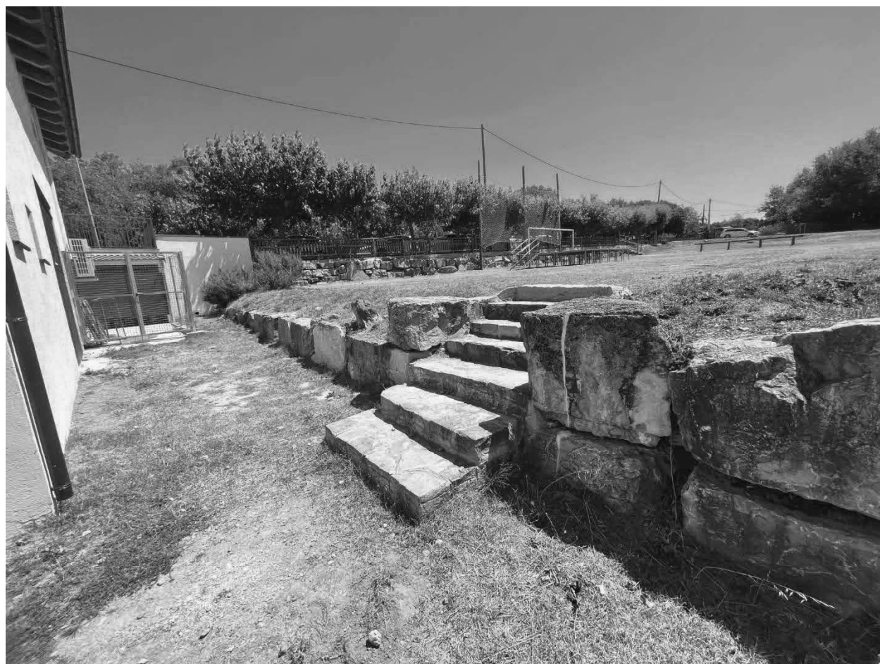
Imatge de l'emmagatzematge de les bombones de butà i de les escales del mur de rocalla de la part nord-oest.
