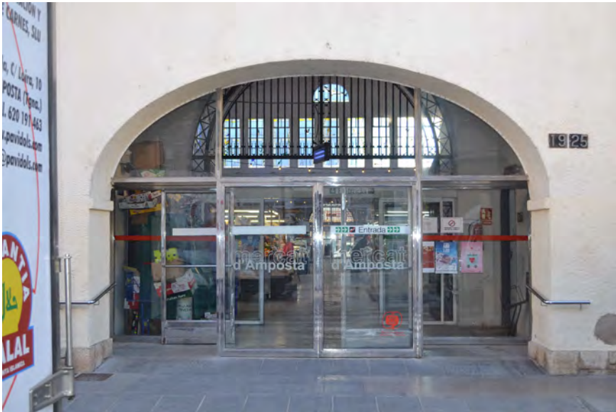
Façana Carrer Tarragona
