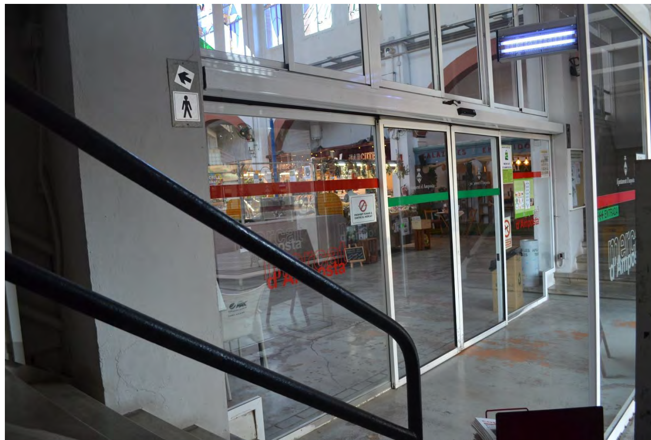
Porta interior automàtica accés avinguda Alcalde Palau.
