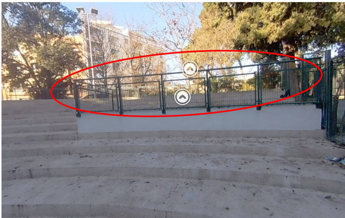
Foto 9. Reforma alçada de la barana de la plataforma per a persones amb mobilitat reduïda
