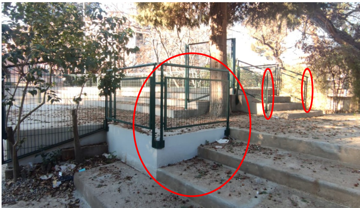
Foto 6. Reforma de la plataforma de mobilitat reduïda i baranes accés grades
