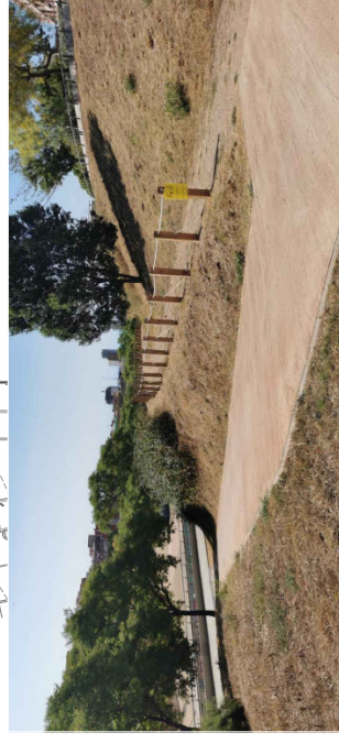
1. Camí pavimentat amb ferrimig escolorit amb pintura a l'òxid.
