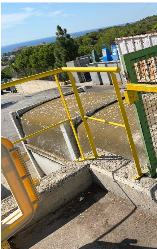
Detalle de balla, donde se instalará un rodapié inferior.
