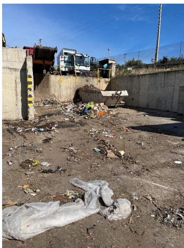
Detalle de zona de generación de aguas contaminadas con lixiviados y sólidos, con riesgo de vertido e infiltración en subsuelo.
