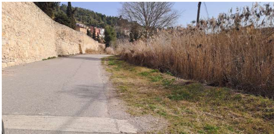
Estado del tramo urbano de la riera, Enero 2023.
