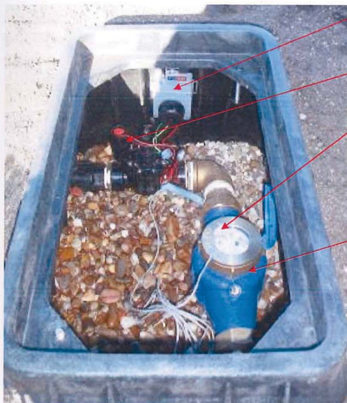
Instal·lació d'un comptador telegestionat amb el sistema SAMCLA® SCR100
