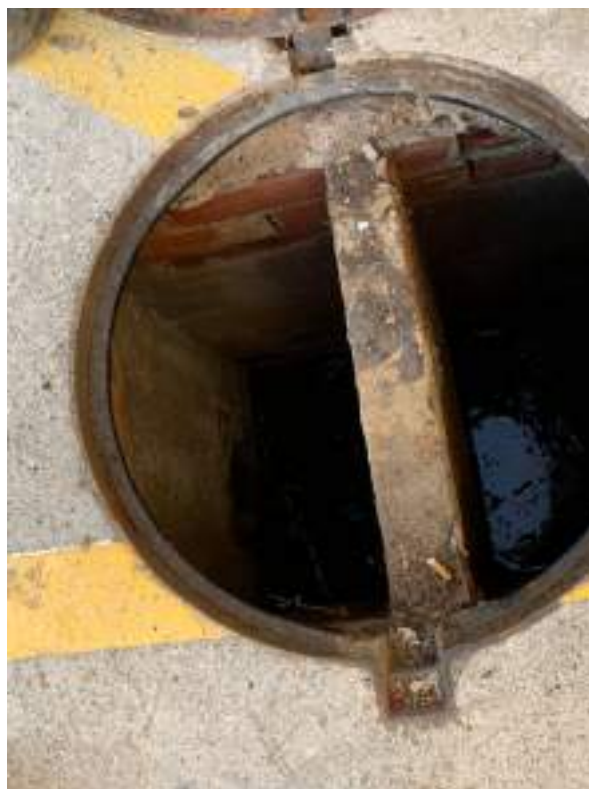
Arqueta sifònica inspeccionada
