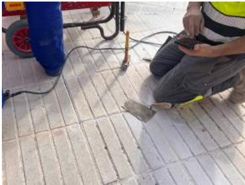
1.- Paviment de panot prefabricat
