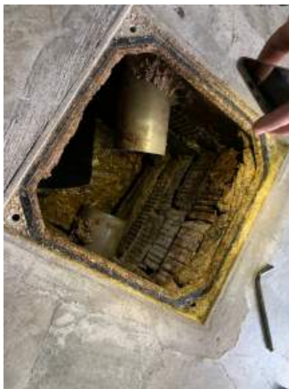
Arqueta de pas inspeccionada
