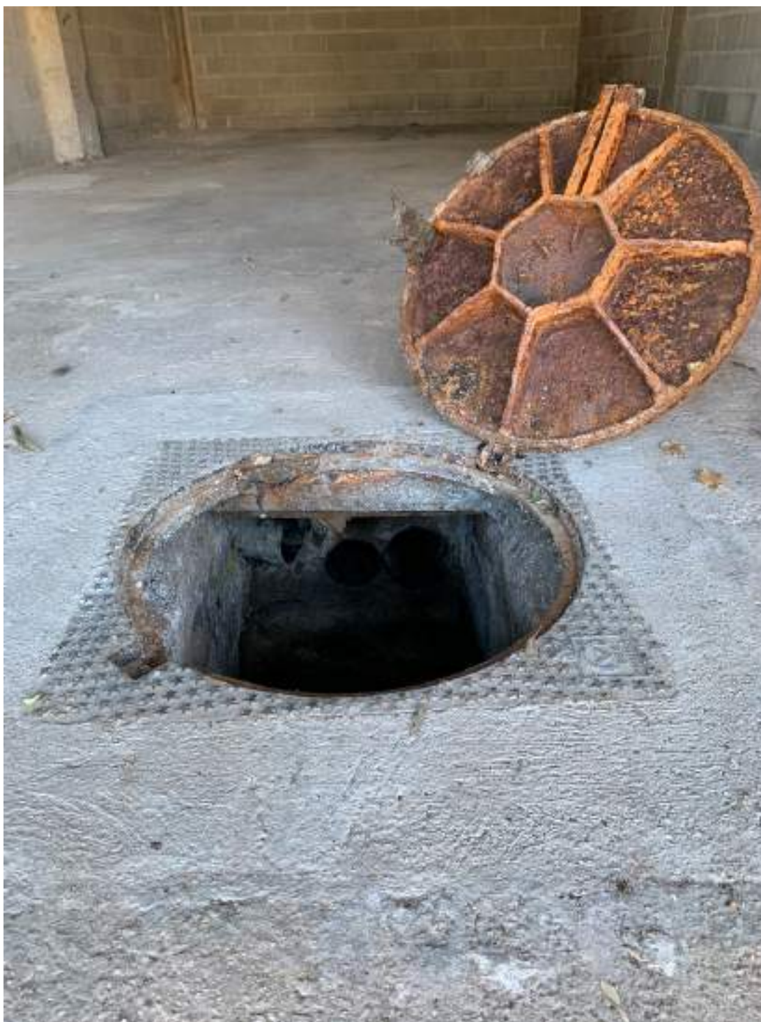
Arqueta de pas inspeccionada
