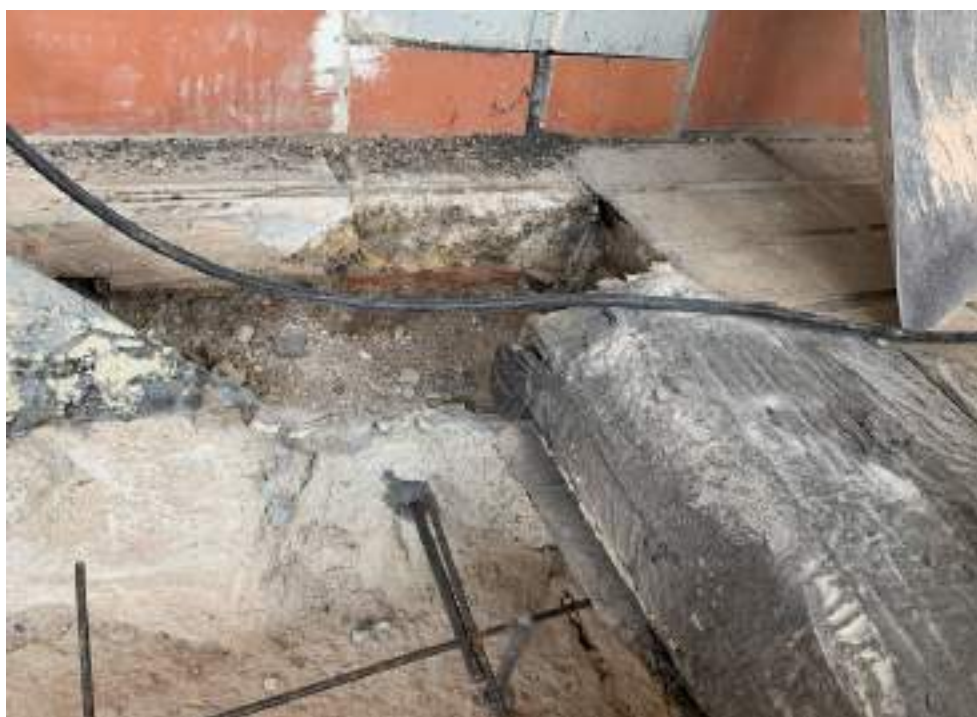
Remat tela asfàtica i paviment
