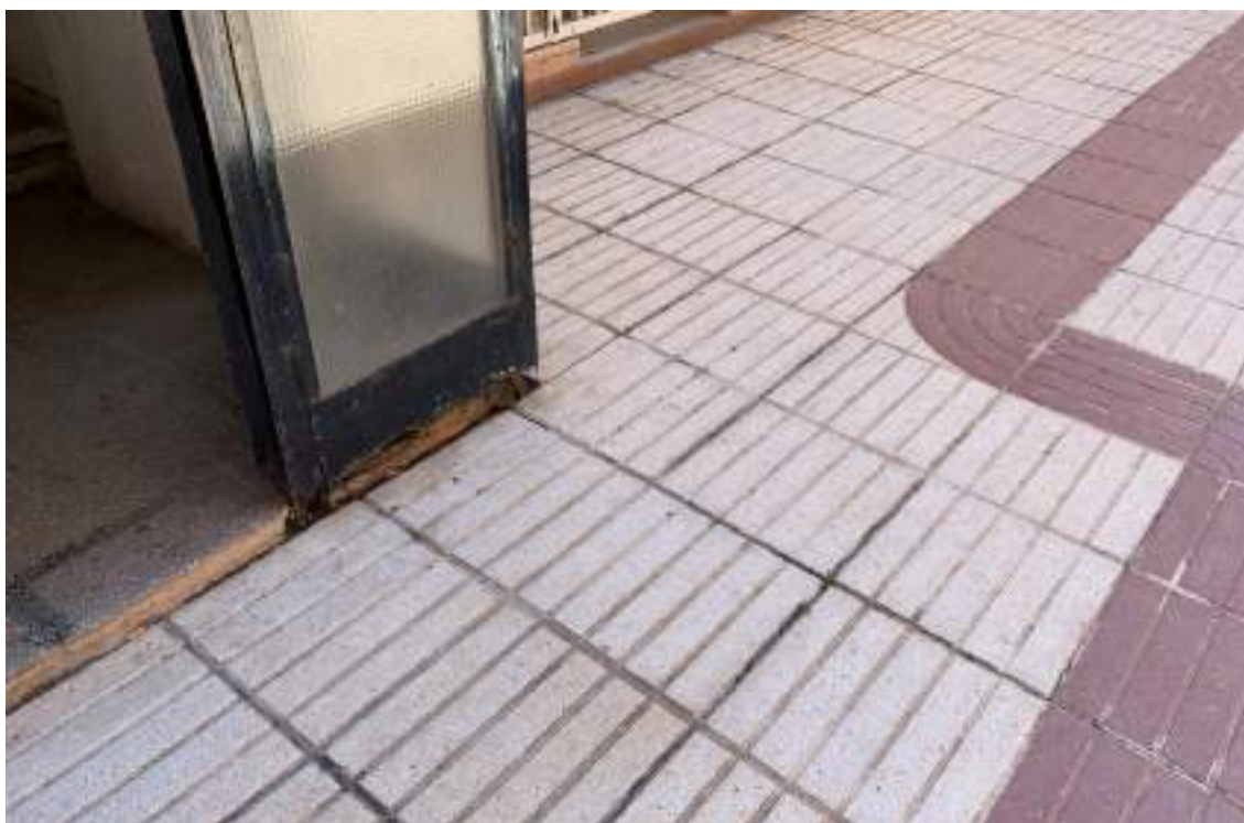
Trobada de coberta amb vestíbul d'habitatges
