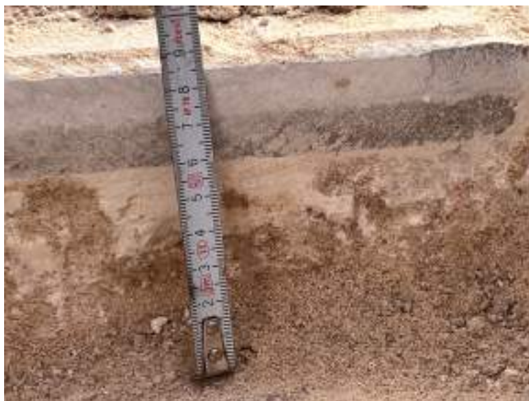
6.- Detall de gruixos de morter i panot
