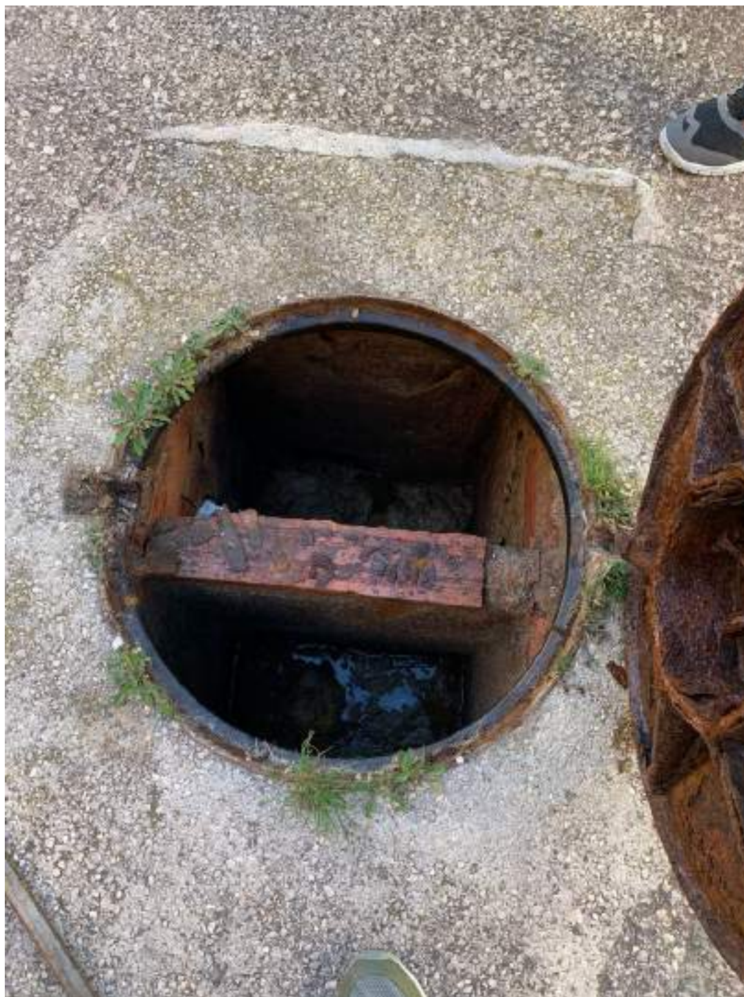
Arqueta sifònica inspeccionada
