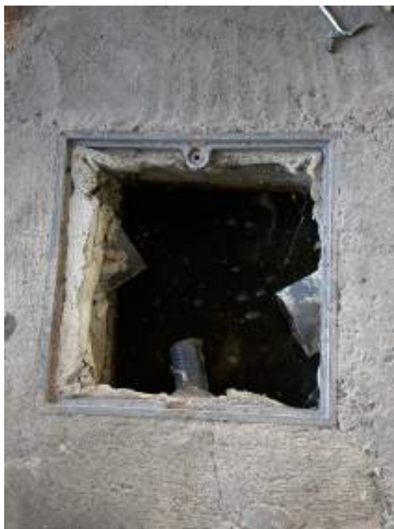
Arqueta de pas inspeccionada
