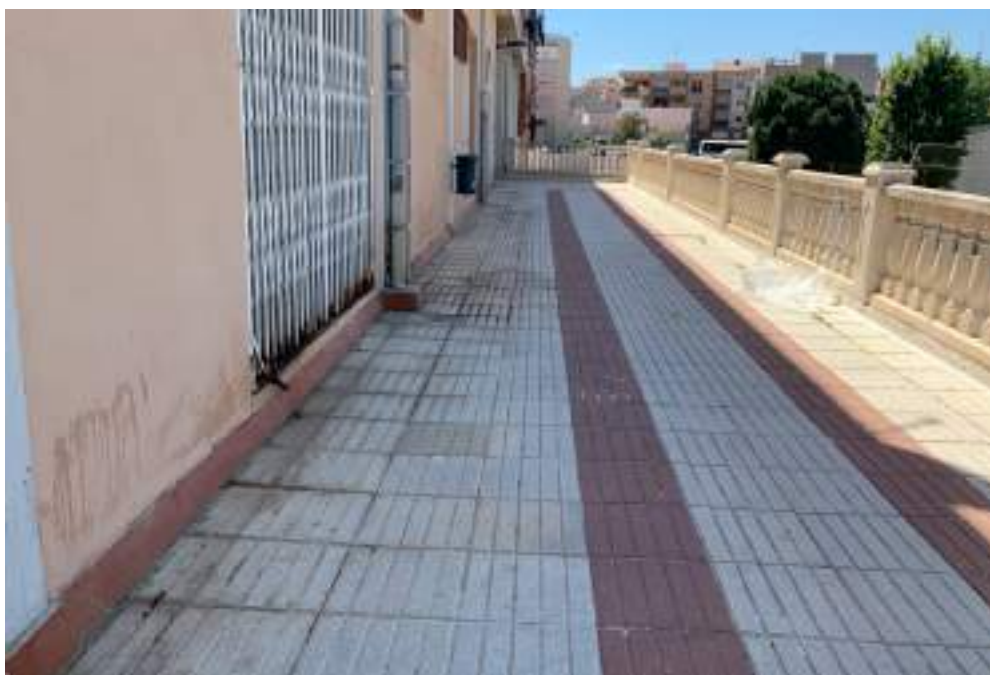
Aspecte general de coberta
