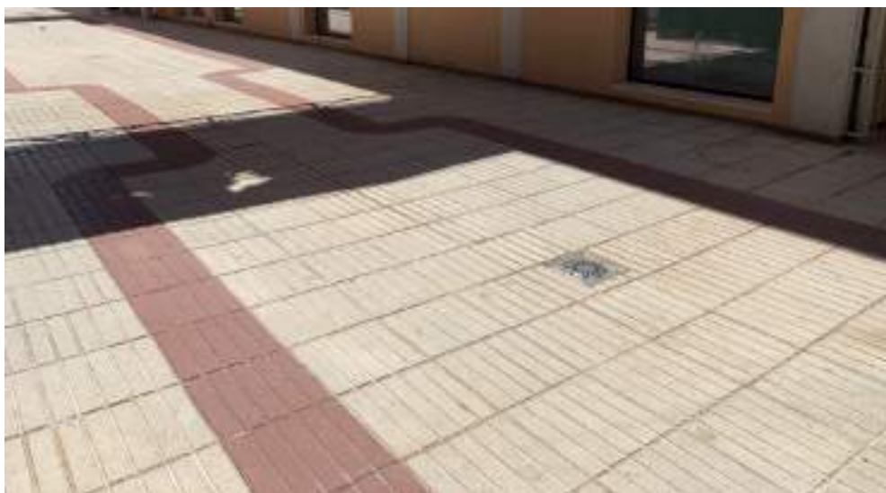
Aspecte general de coberta
