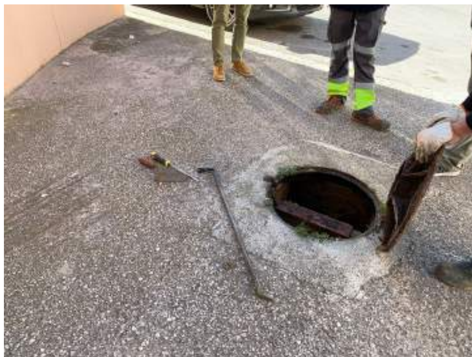
Arqueta sifònica inspeccionada
