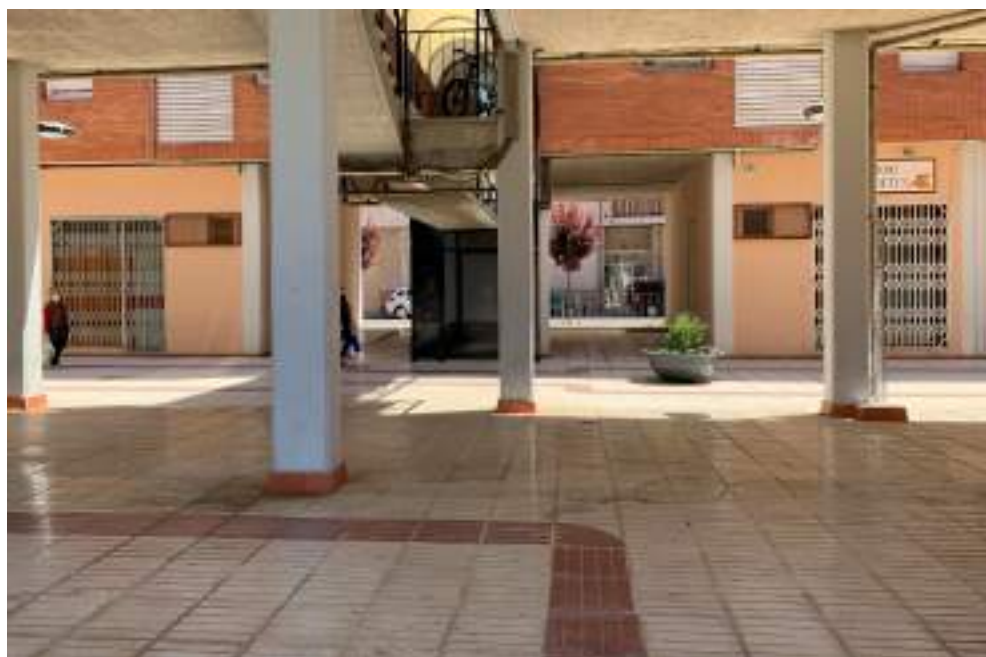
Aspecte general de coberta
