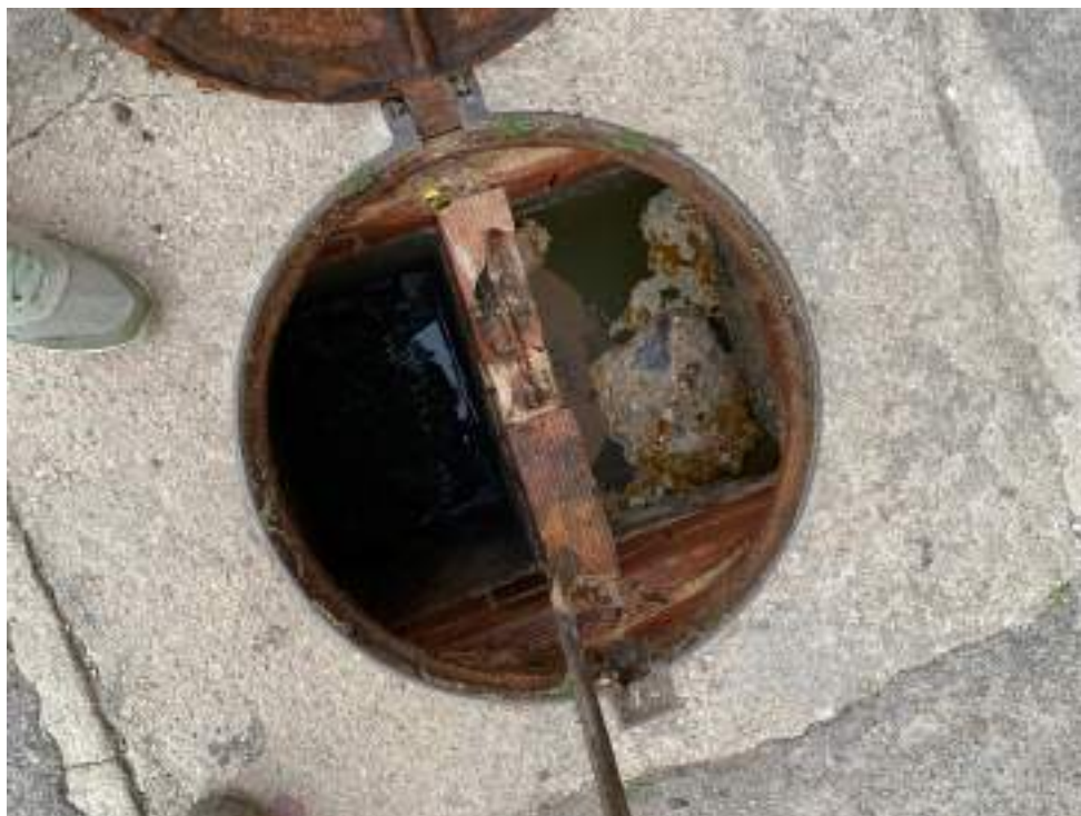
Arqueta sifònica inspeccionada
