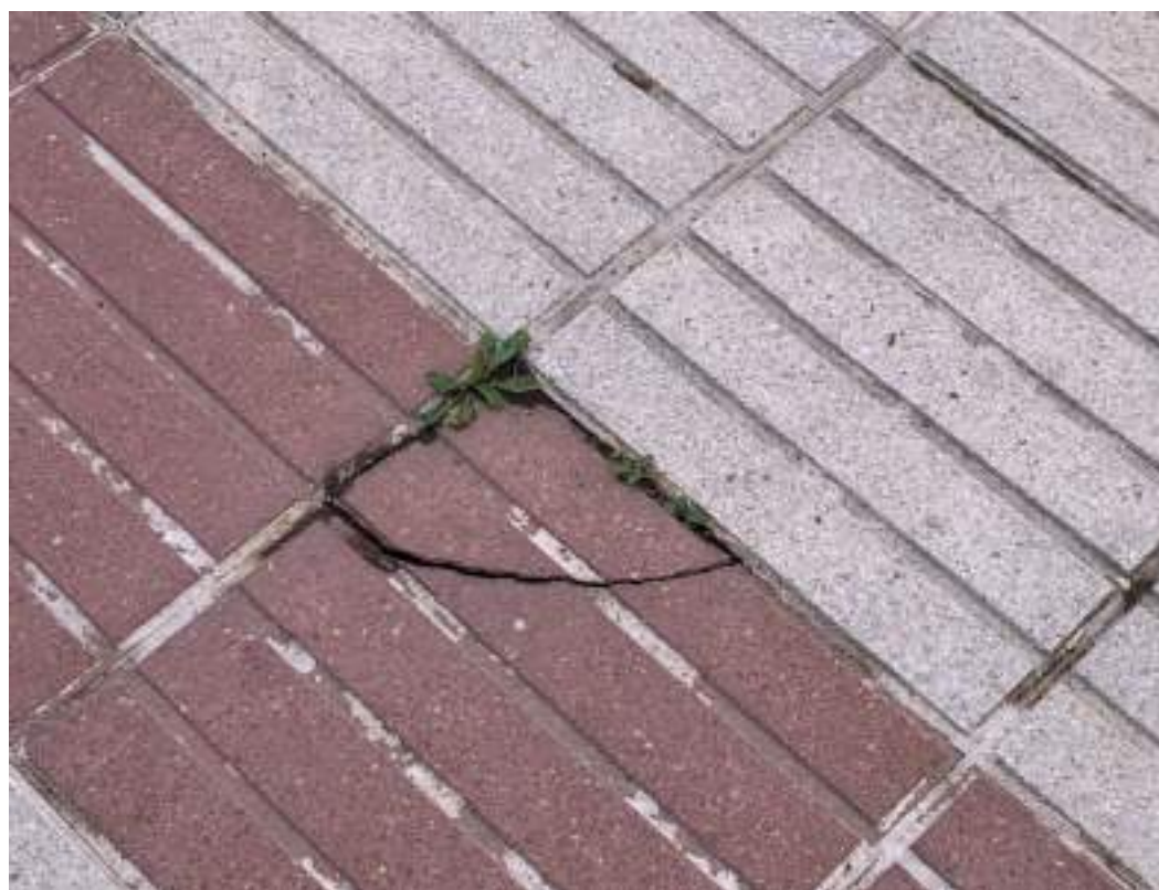
Trencament a peça de paviment de coberta
