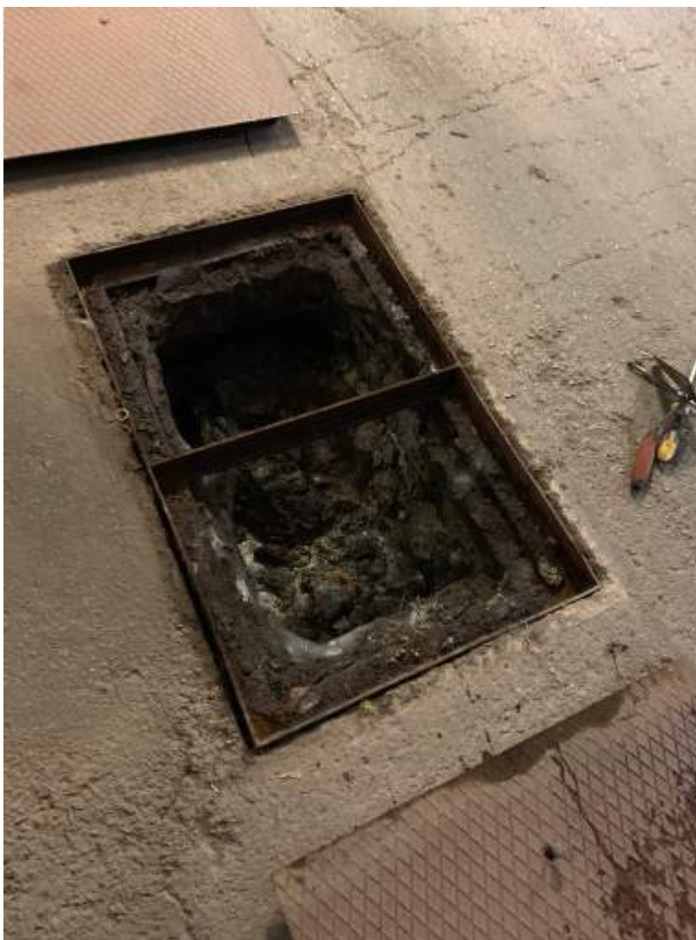
Arqueta de pas inspeccionada
