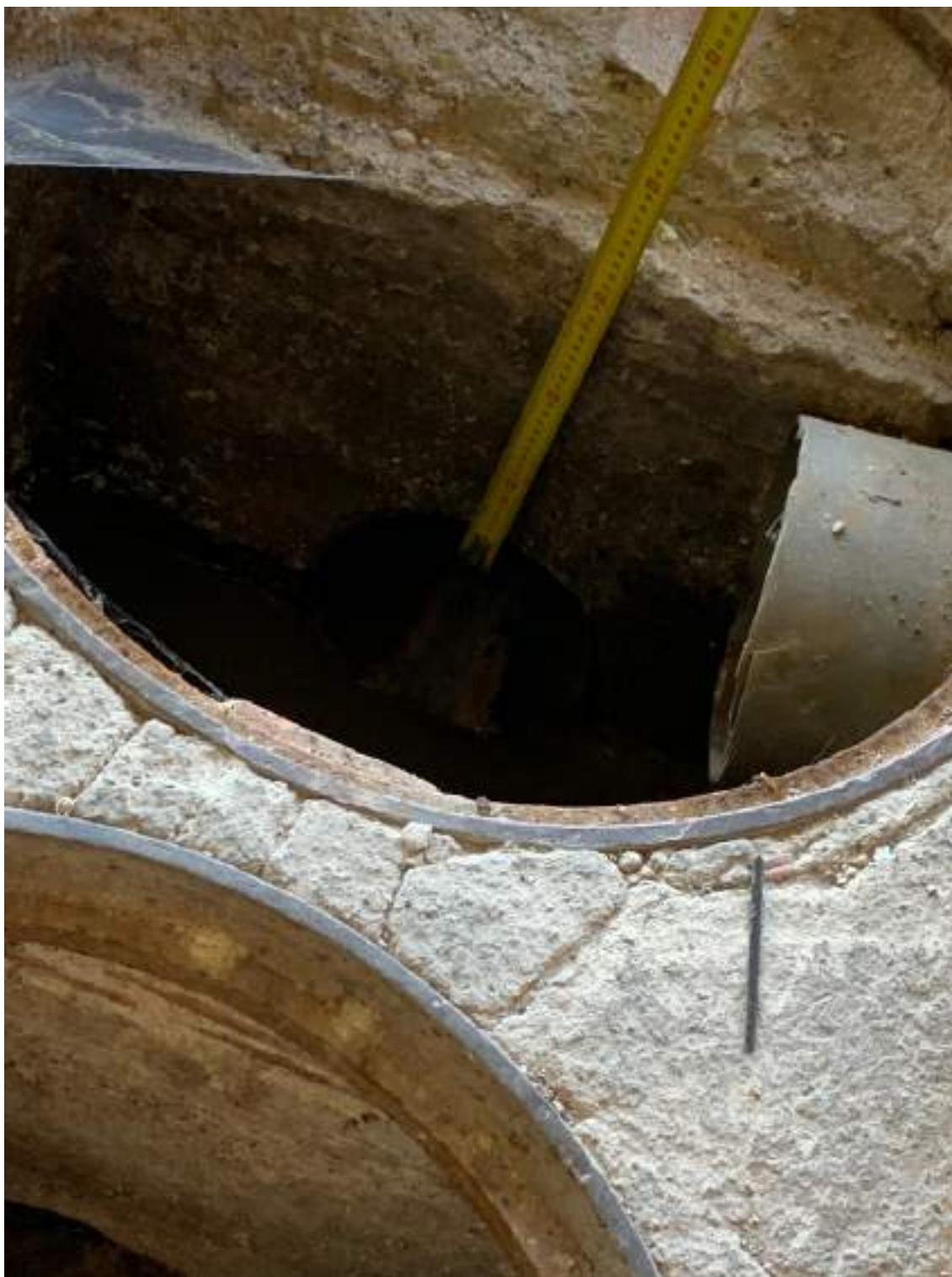
Arqueta sifònica inspeccionada
