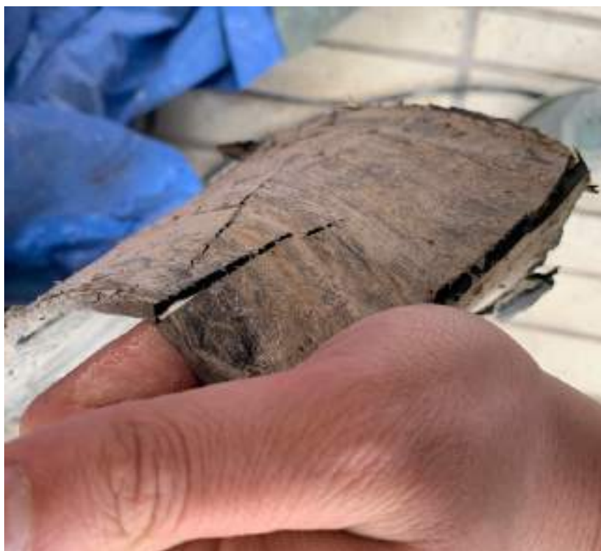
Prova de ruptura de tela asfàtica pressionant amb les mans
