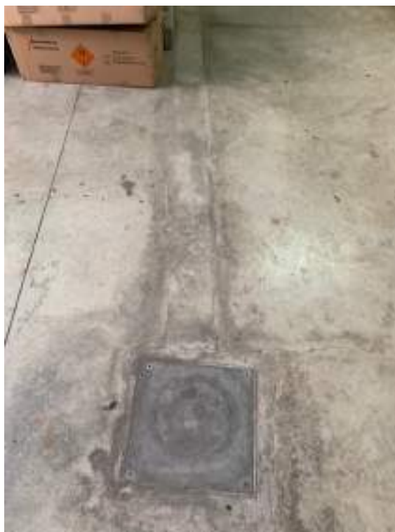
Arqueta de pas creada per reparar un embús al col·lector
