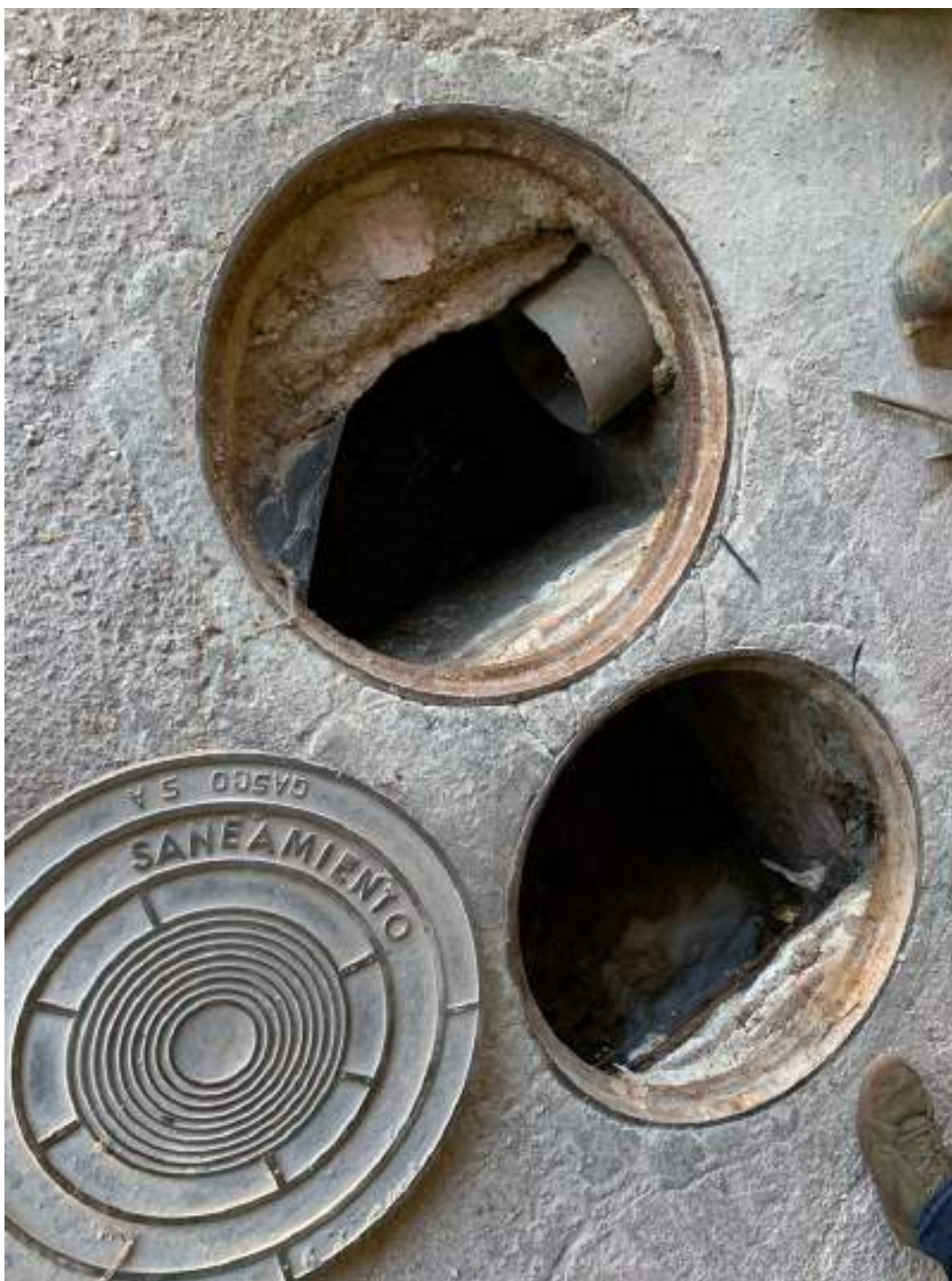
Arqueta sifònica inspeccionada
