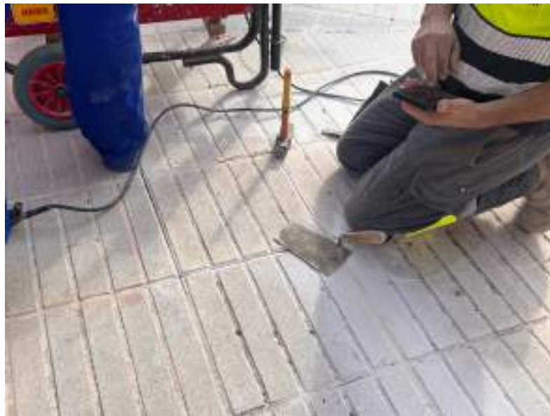
1.- Paviment de panot prefabricat
