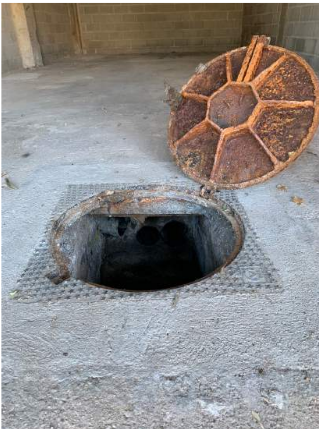
Arqueta de pas inspeccionada
