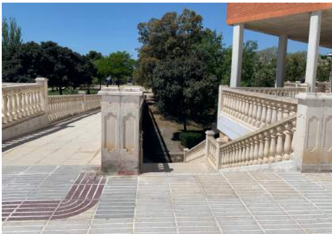
Trobada de coberta amb escales i rampa
