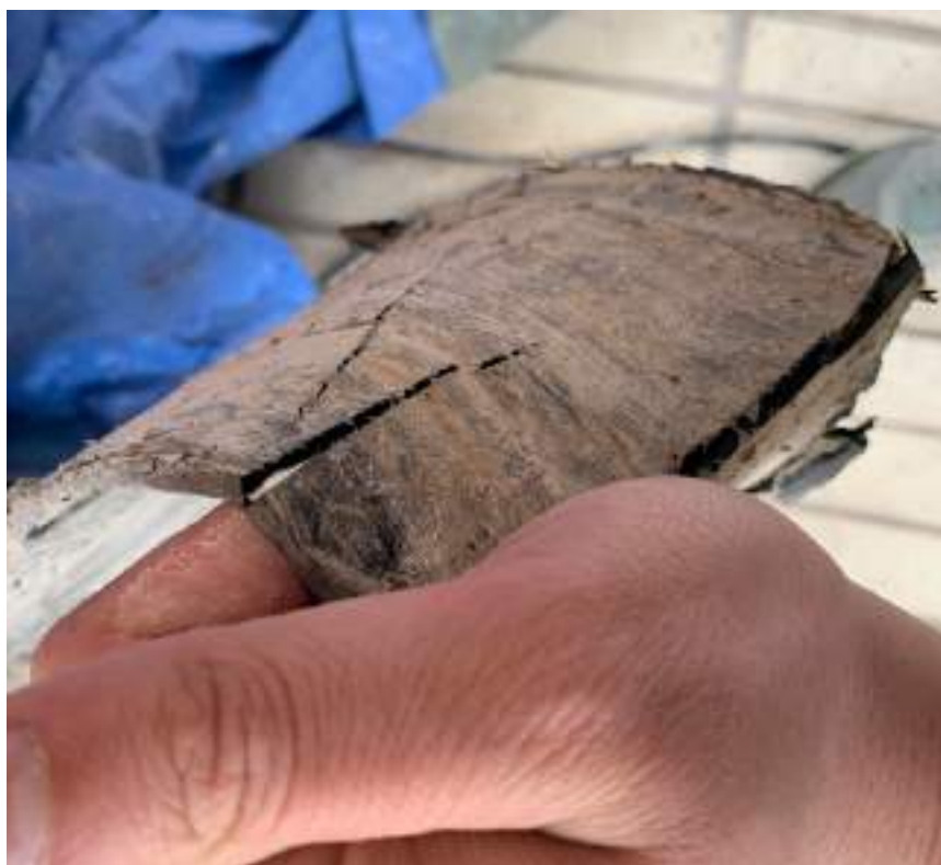
Prova de ruptura de tela asfàltica pressionant amb les mans
