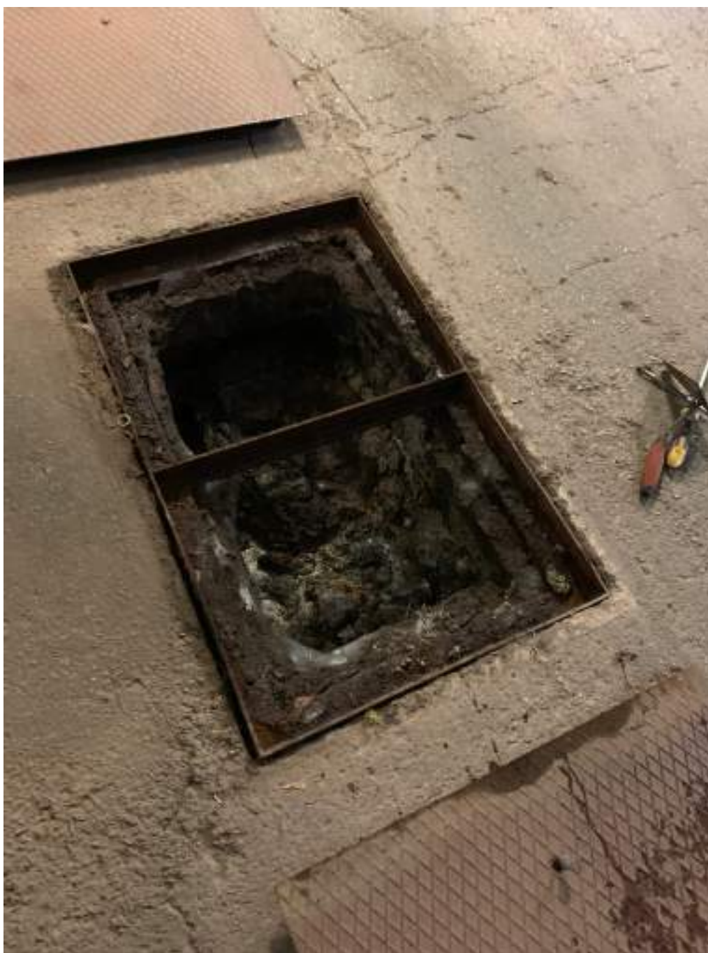
Arqueta de pas inspeccionada
