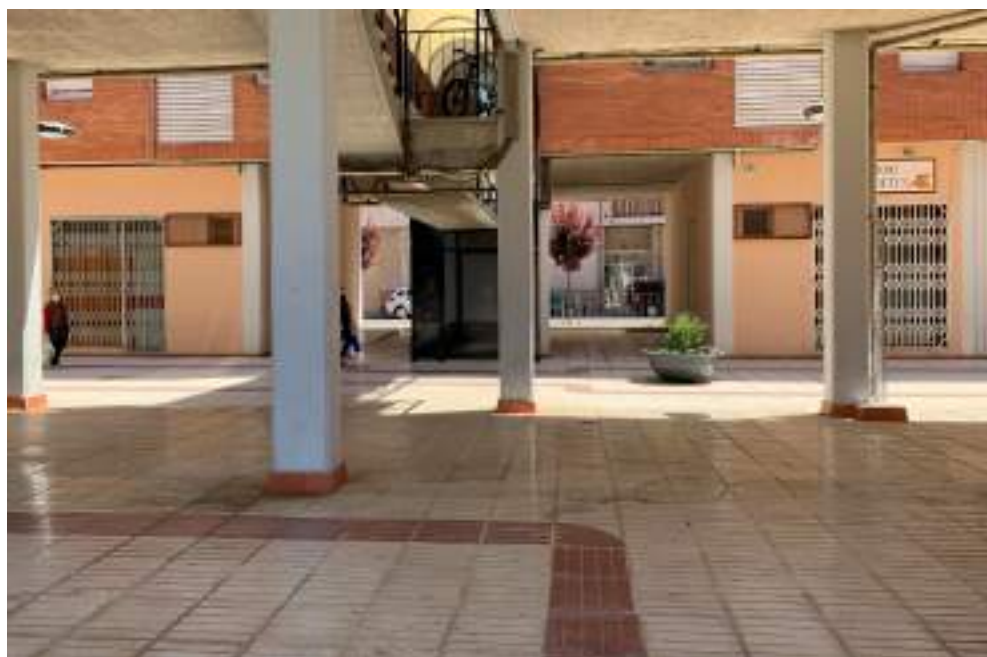
Aspecte general de coberta
