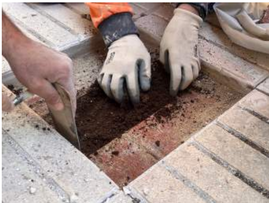
4.- Sorra i tela asfàltica sota rasella ceràmica
