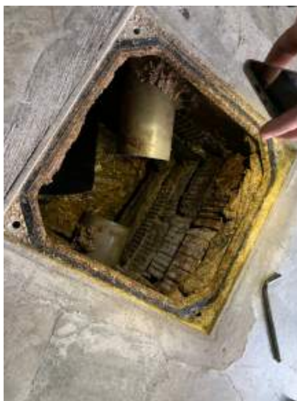
Arqueta de pas inspeccionada
