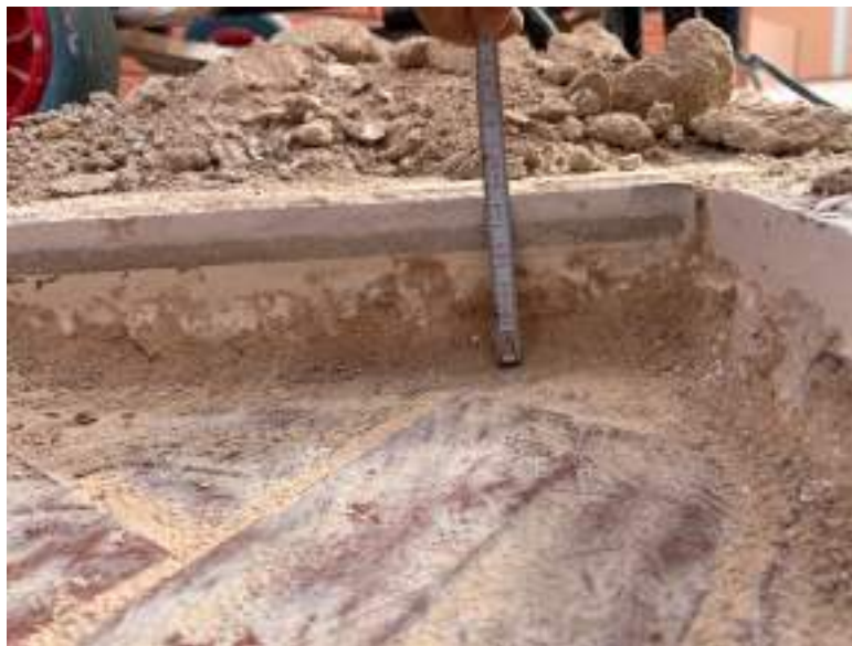
5.- Detall de gruix de morter i panot
