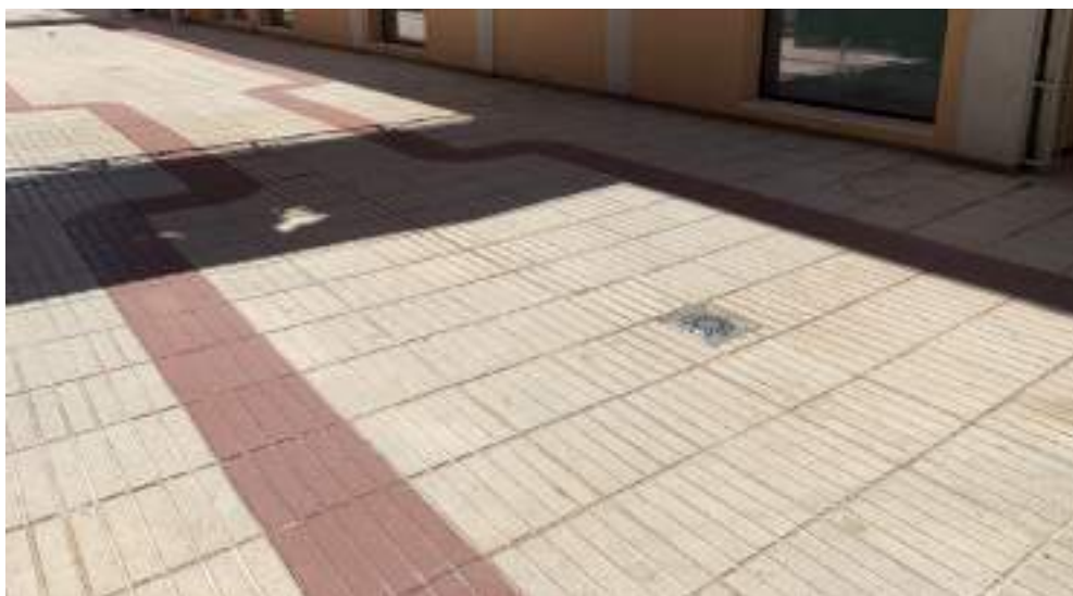
Aspecte general de coberta
