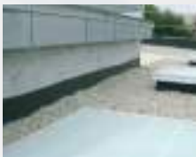
Impermeabilización de puntos de encuentro con paramentos verticales con TexTop .
