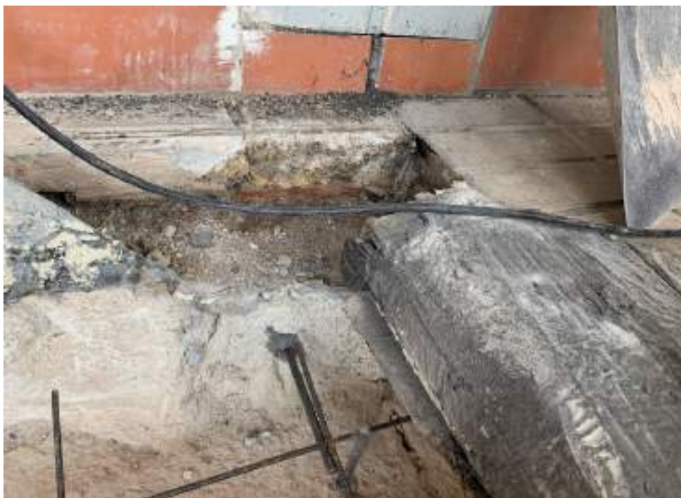
Remat tela asfàltica i paviment
