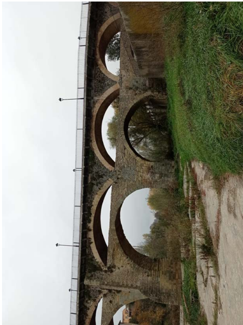
Presència de vegetació en tot l'alçat del pont – Foto 23.11.21
