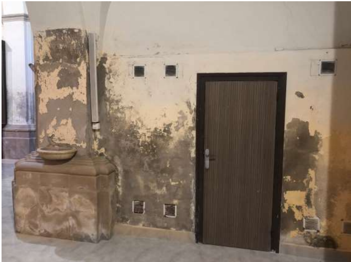
Fot. 2 Imatge de les humitats per capil·laritat en murs interiors
