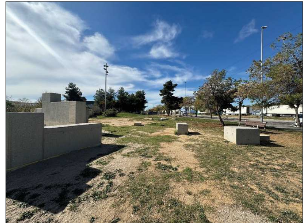
Fotografia núm. 06 Vista dels elements Espai Parkour existent 3
