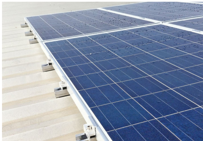
Imatge 3.- Exemple d'estructura coplanar MultiRail sobre teulada trapezoidal (Font: K2 Systems)
