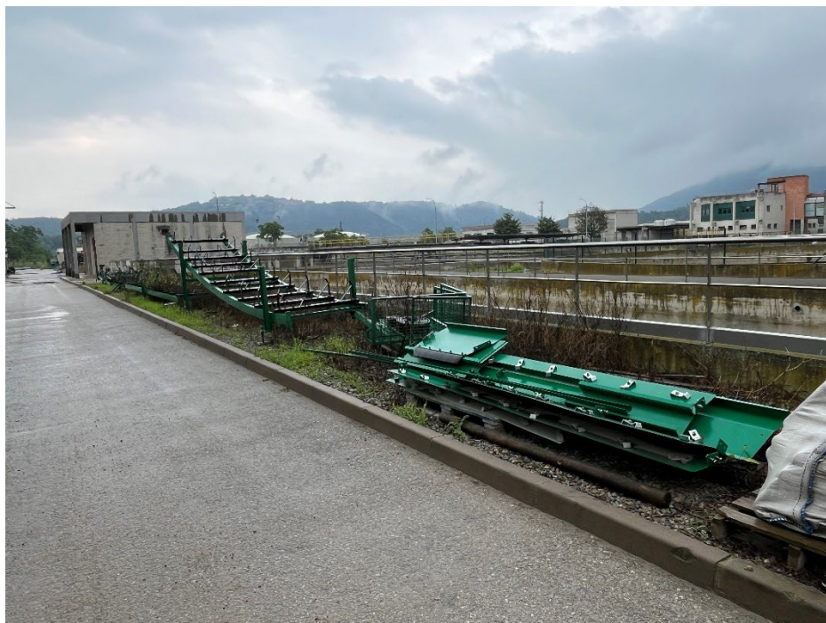
Imatge 3 – Vista dels suports existents emmagatzemats del sistema d'extracció d'escòries
