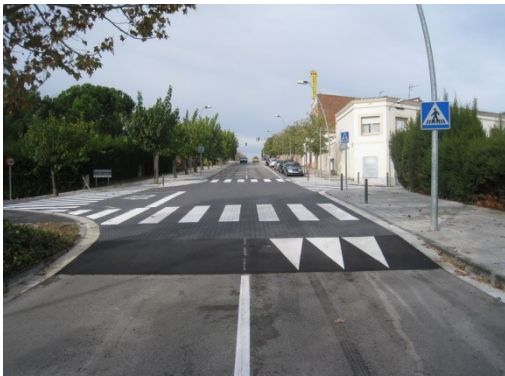
Plataforma reductora de velocitat en cruïlla
