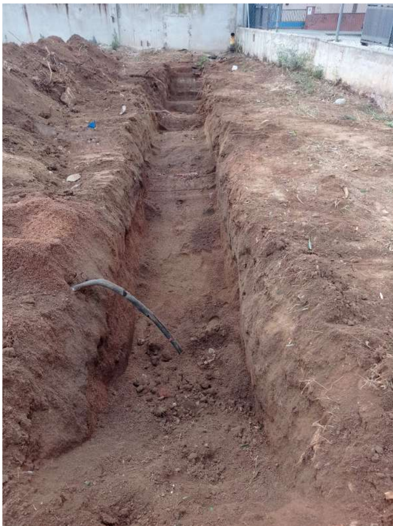
Imatge MAD'22.12. Vista de la rasa 28, des de l'est
