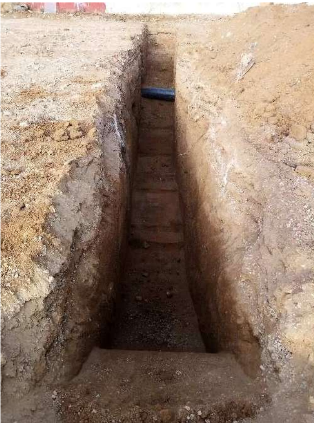
imatge MAD'22.5 Vista de la rasa 7 des del sud
