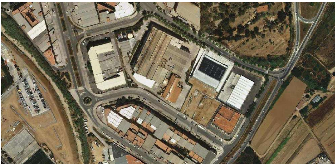
Imatge del vol aeri del 2009, on es pot observar les naus de la fàbrica de vidre, que encara no s'havia enderrocada.
