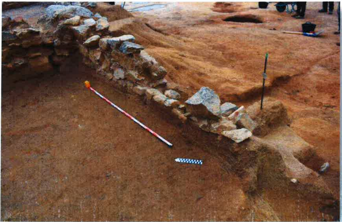
Vista de la fonamentació UE 192.
