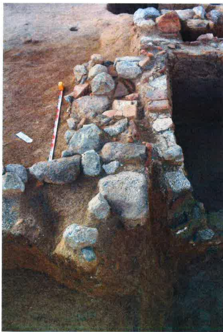
Vista de la fonamentació UE 1060.
