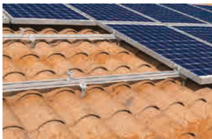
Detalle: Posicionamiento de las abrazaderas
