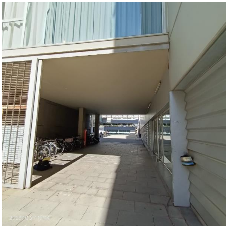
Imatge 14. Porta d'accés per on ha d'entrar la plataforma elevadora
