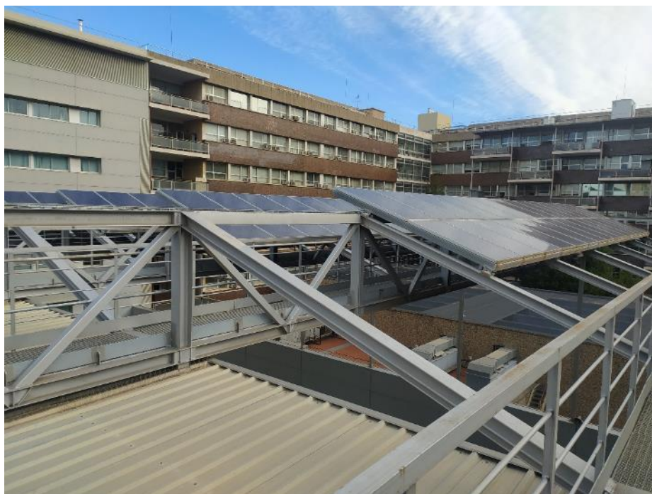
Imatge 1. Panells existents a retirar
