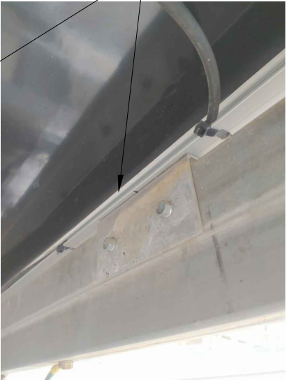
GRAPES D'ANCORATGE DE PANELS A MÒDULS D'ESTRUCTURA (A RETIRAR)
