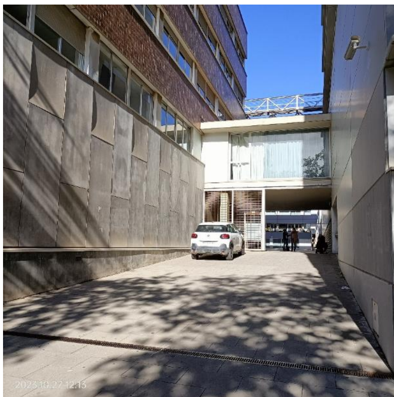
Imatge 13. Passadís accés al pati interior
