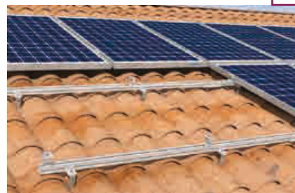
Detalle: Posicionamiento de las abrazaderas
