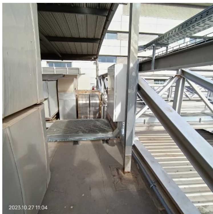
Imatge 5. Zona prevista per a instal·lar l'inversor i els quadres de protecció
