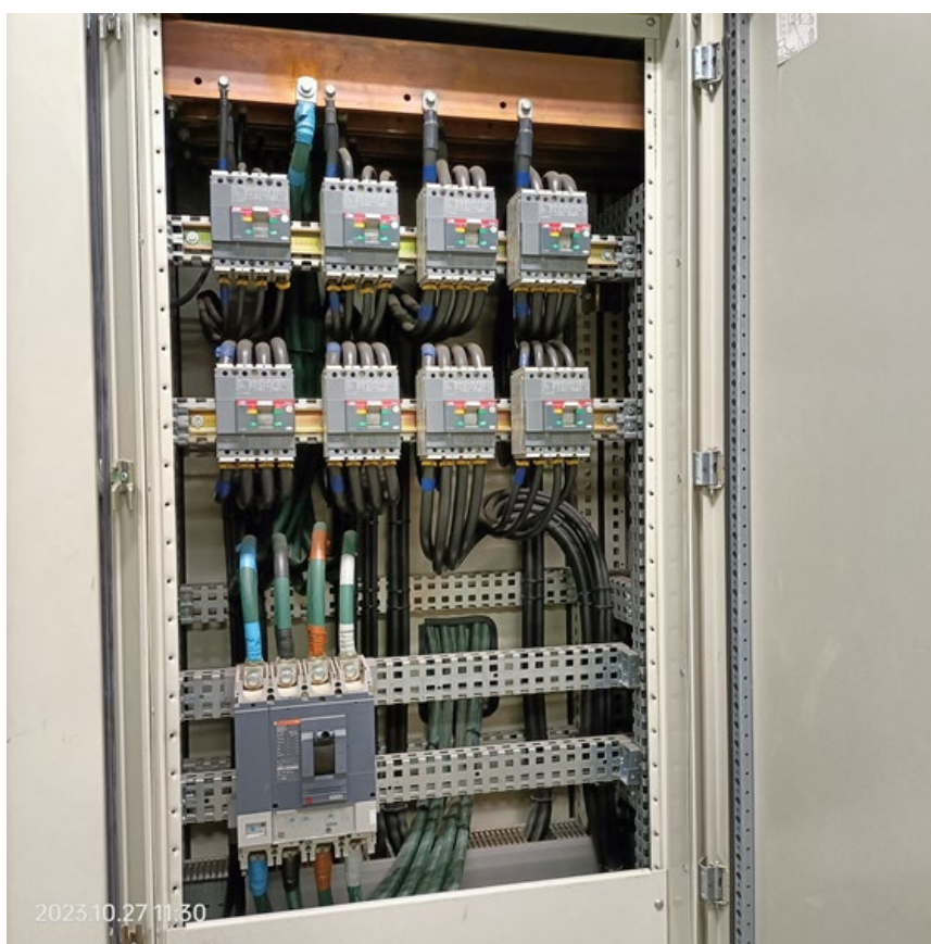
Imatge 10. Espai en s'instal·larà la protecció de la línia de la FV
