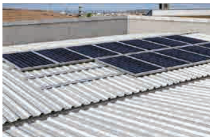
Cubierta industrial en chapa grecada
