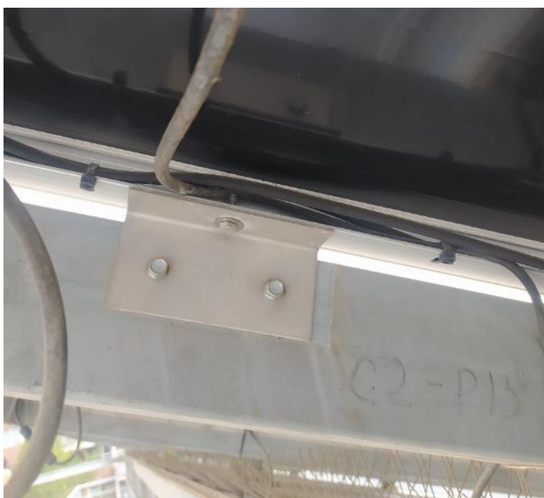
Imatge 4. Fixació panells actuals a retirar
