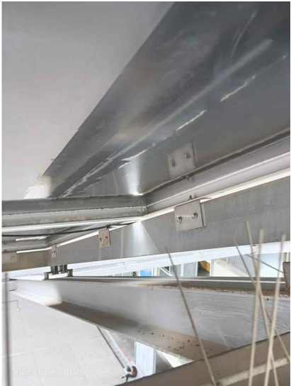
GRAPES D'ANCORATGE DE PANELS A MÒDULS D'ESTRUCTURA (A RETIRAR)
