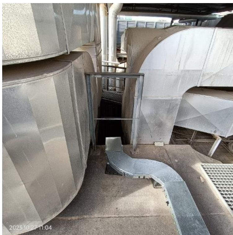
Imatge 6. Muntant en planta coberta per on realitzarà la baixada del cablejat
