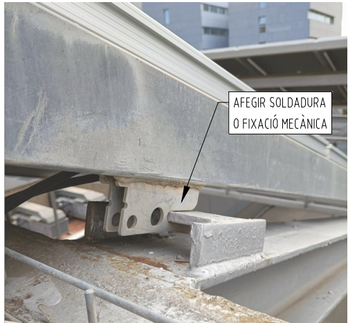
GRAPES D'ANCORATGE DE PANELS A MÒDULS D'ESTRUCTURA (A RETIRAR)
