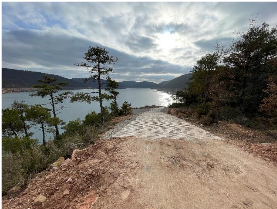
Figura 11: Centre activitats nàutiques (magatzem) (1)
