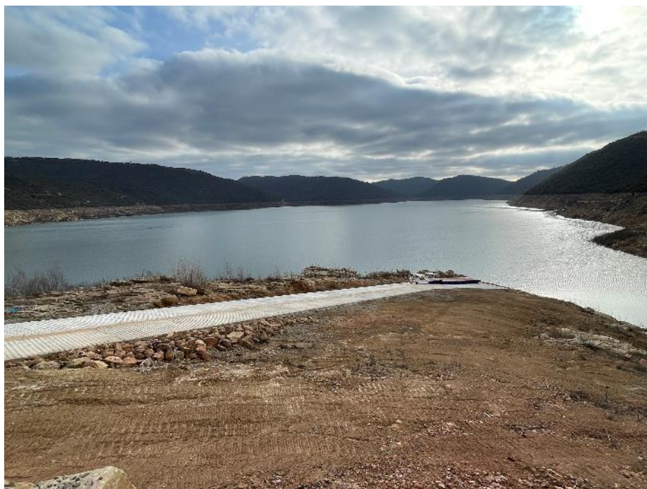
Figura 13: Centre activitats nàutiques (magatzem) (3)
