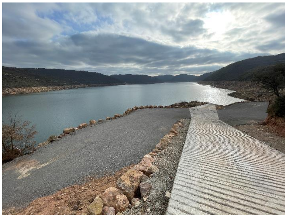
Figura 12: Centre activitats nàutiques (magatzem) (2)
