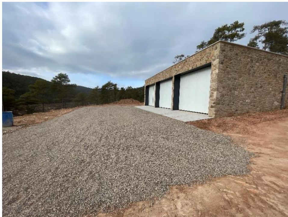
Figura 15: Centre activitats nàutiques (magatzem) (5)
