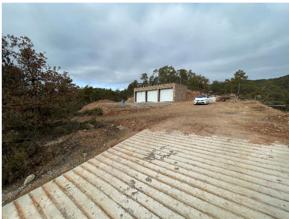
Figura 16: Centre activitats nàutiques (magatzem) (6)
