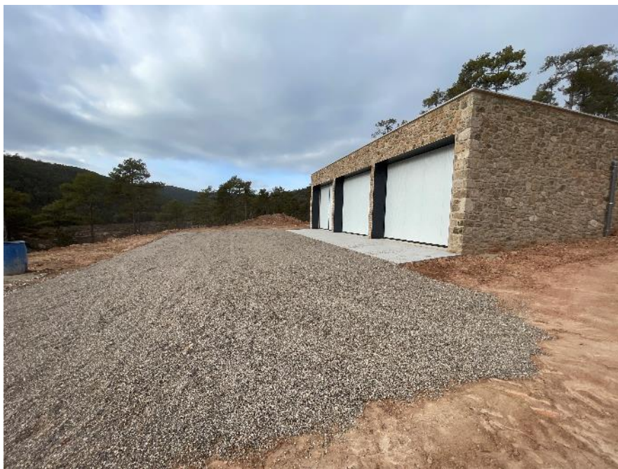
Imatge 10: Edifici Centre d'activitats nàutiques (magatzem)
