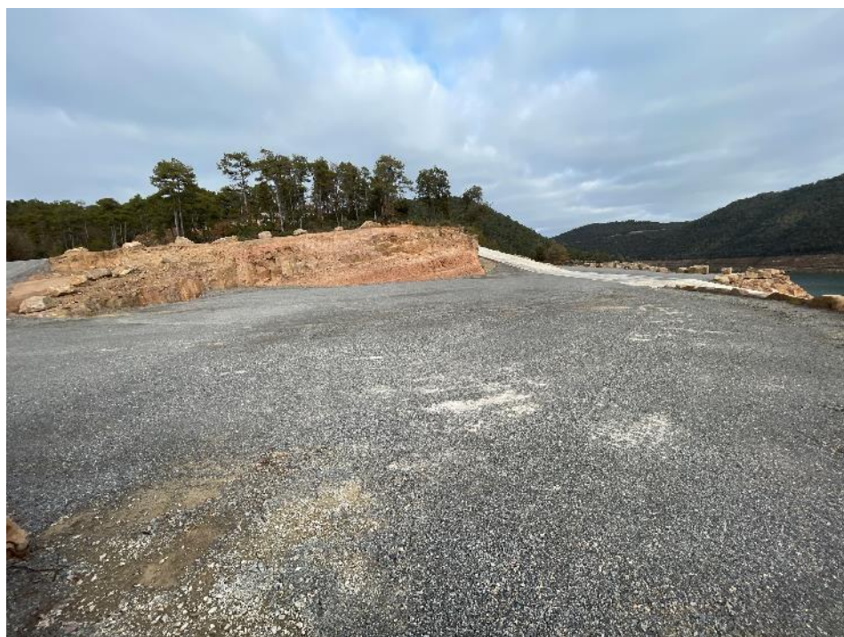
Figura 14: Centre activitats nàutiques (magatzem) (4)
