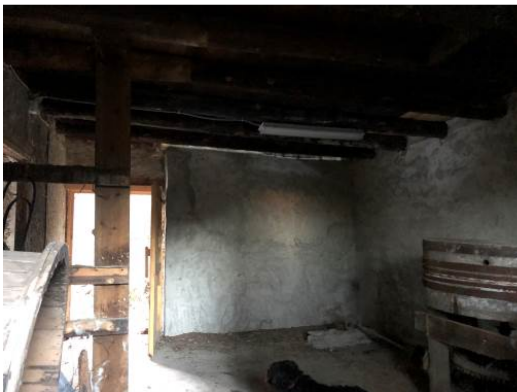
Planta baixa on hi ha la maquinaria de la central hidràulica i les pedres de l'antic moli.
