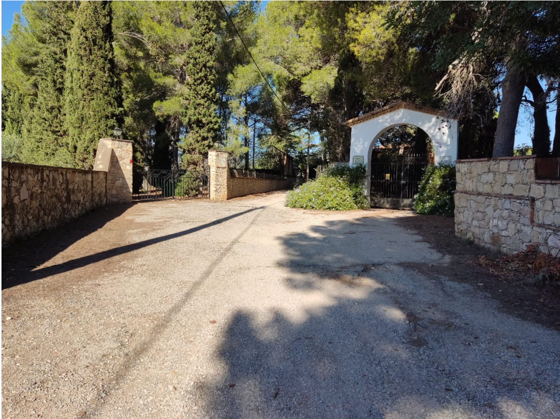
FOTO 11.- TRAM 2.1. PK 0+190. Paviment de regs asfàltics existent. Accessos a masies.
