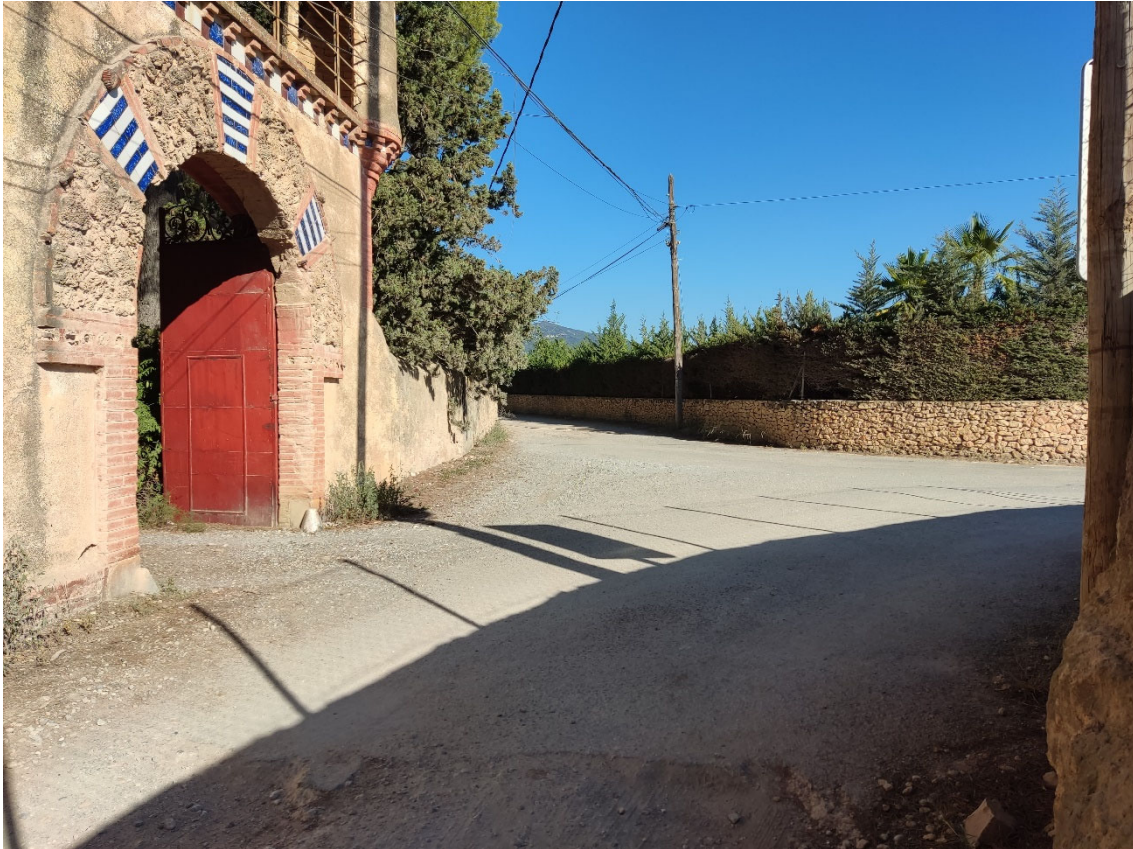
FOTO 7.- TRAM 1. PK 0+729. Paviment de regs asfàltics. Final del Tram 1.
