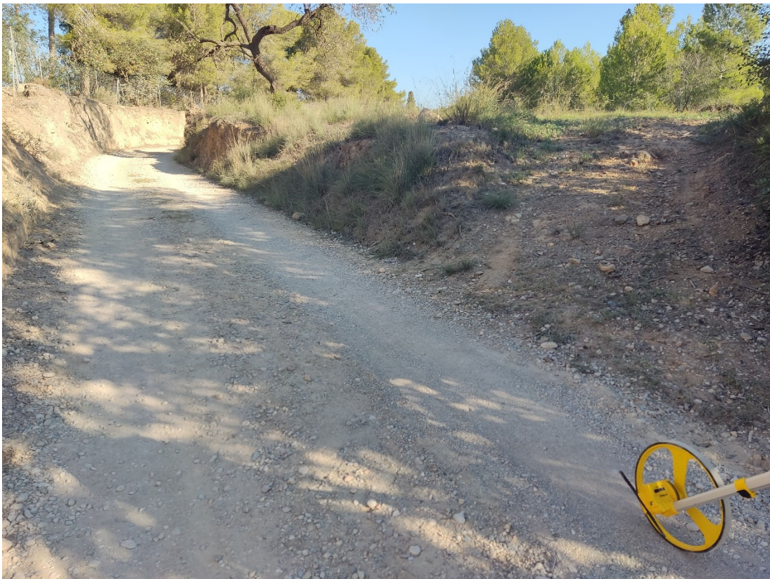
FOTO 2.- TRAM 1. PK 0+110. Camí "en trinxera". Totes les aigües d'escorrentia fan cap al camí, i discorren per ell sense possibilitat d'escapatòria.
