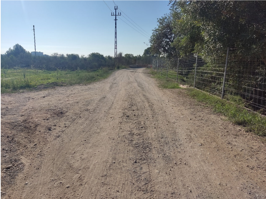
FOTO 1.- TRAM 1. PK 0+040. Vista del pont sobre el FF.CC Línea Lleida – Barcelona. P.K. 0+000.
