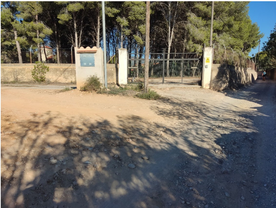
FOTO 4.- TRAM 1. PK 0+420. Accés a finques al marge esquerre.
