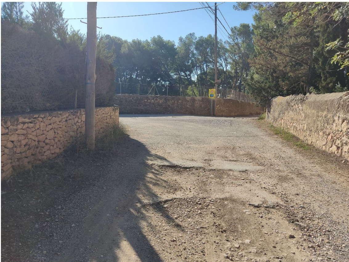
FOTO 8.- TRAM 2.1. PK 0+025. Vista del P.K. 0+000 del Tram 2. Restes de l'antic paviment.
