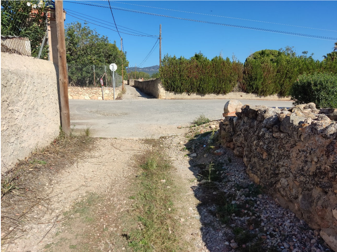
FOTO 13.- TRAM 2.2. PK 0+129. Final del tram. Connexió amb l'accés a la Plana d'en Berga.
