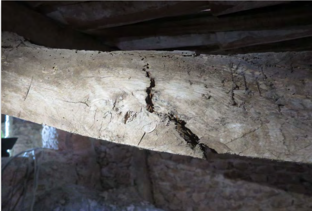
Sostre de la planta coberta (PC), església. Element PCB21 (trençallums). Imatge 146 Trencament de les fibres Fletxa significativa aparent
