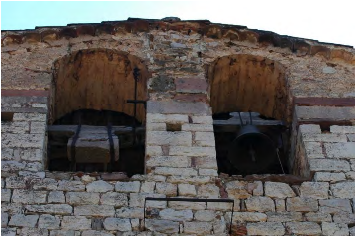
Detall coberta campanar. Font B. Onecha, 2016
