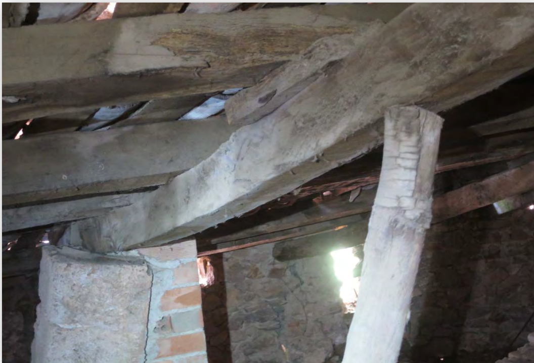
Sostre de la planta coberta (PC), església. Element PCB22 (trençallums). Imatge 144 Fletxa significativa aparent Apuntament de fusta
