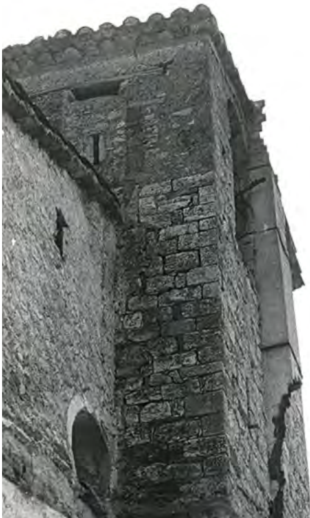
Arxiu històric municipal. Detall campanar façana oest de l'església.
