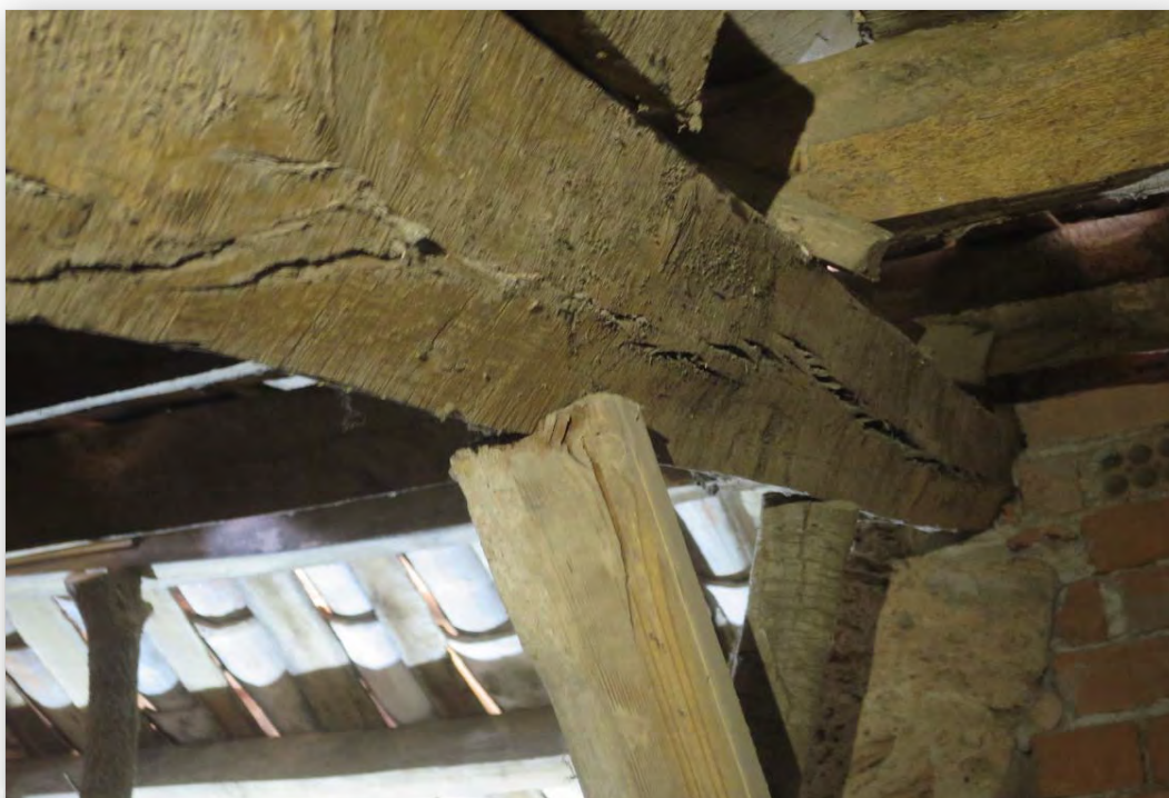
Sostre de la planta coberta (PC), església. Element PCB23 (trençallums). Imatge 136 Clivelles significatives en el pla horitzontal Torsió i apuntalament de fusta
