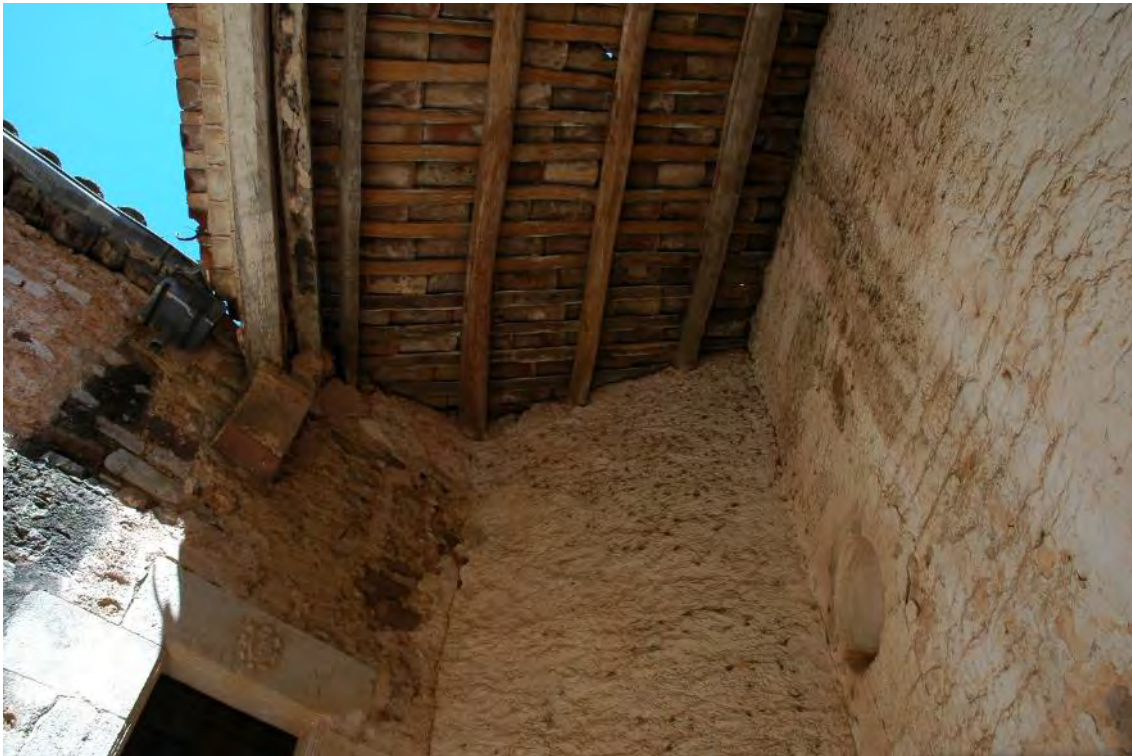
Detall cara inferior porxo façana sud. Font B. Onecha, 2016
