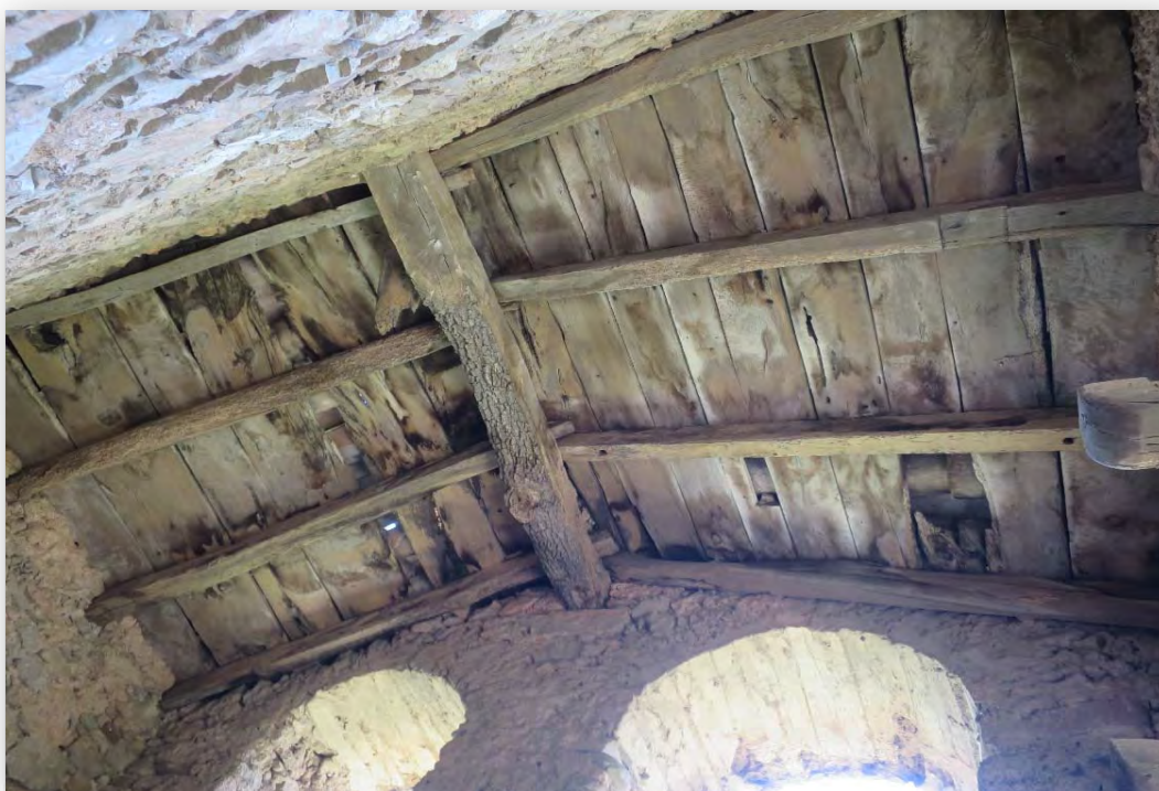
Sostre de la planta coberta (PC), campanar. Imatge 127 Vista general
