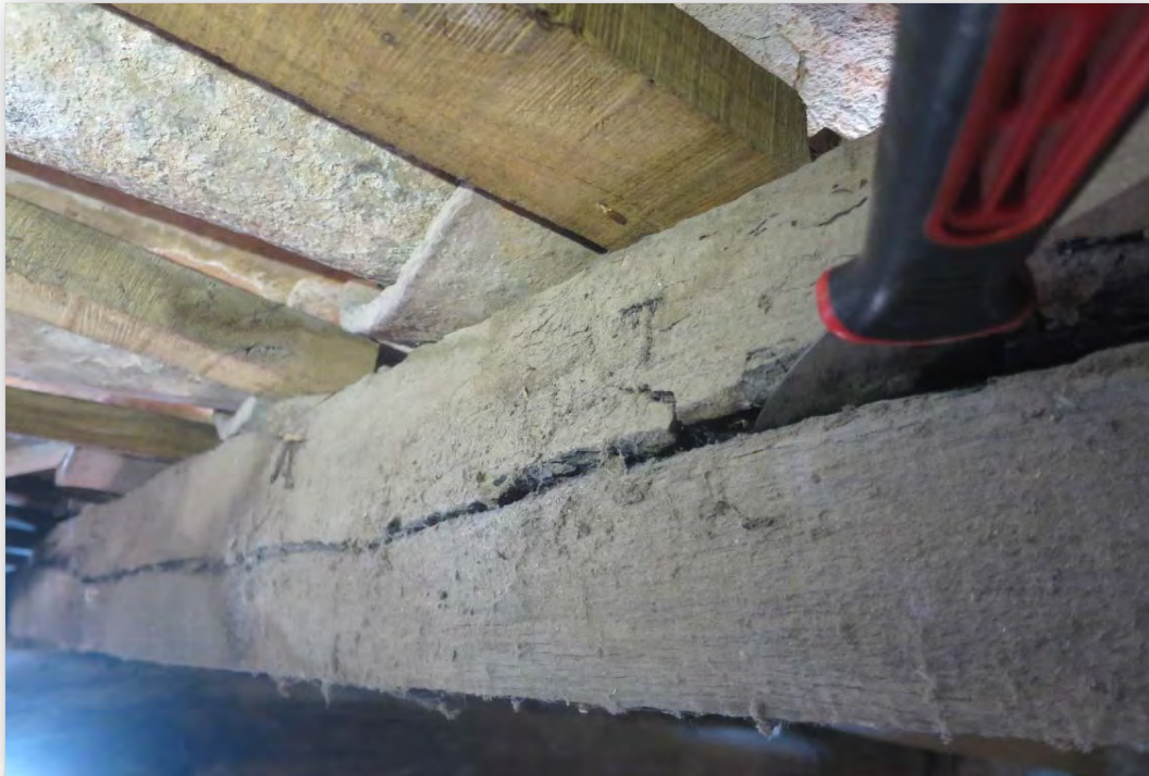
Sostre de la planta coberta (PC), església. Element PCA9. Imatge 131 Clivelles significatives en el pla horitzontal
