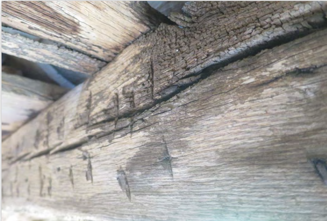
Sostre de la planta coberta (PC), campanar. Element PCE3.2. Imatge 150 Clivelles significatives en el pla horitzontal
