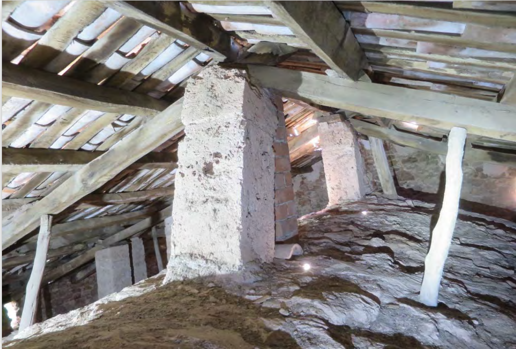
Sostre de la planta coberta (PC), església. Imatge 126 Vista general
