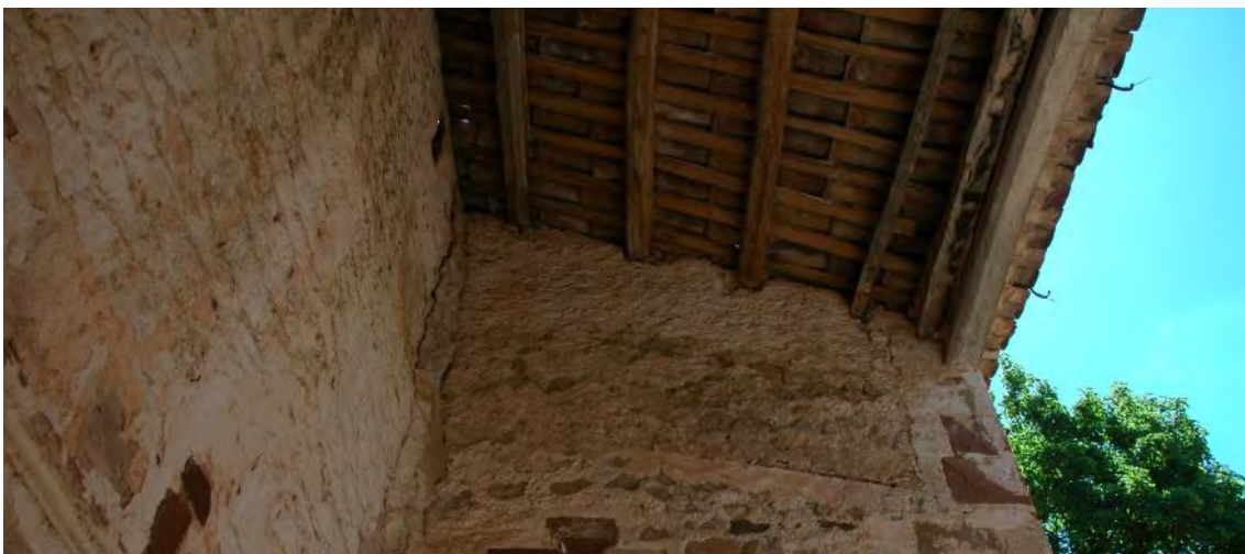
Detall cara inferior porxo façana sud. Font B. Onecha, 2016
