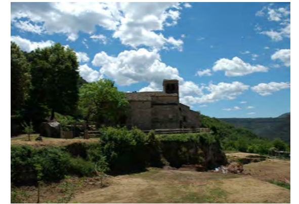
VISTA GENERAL NORD
