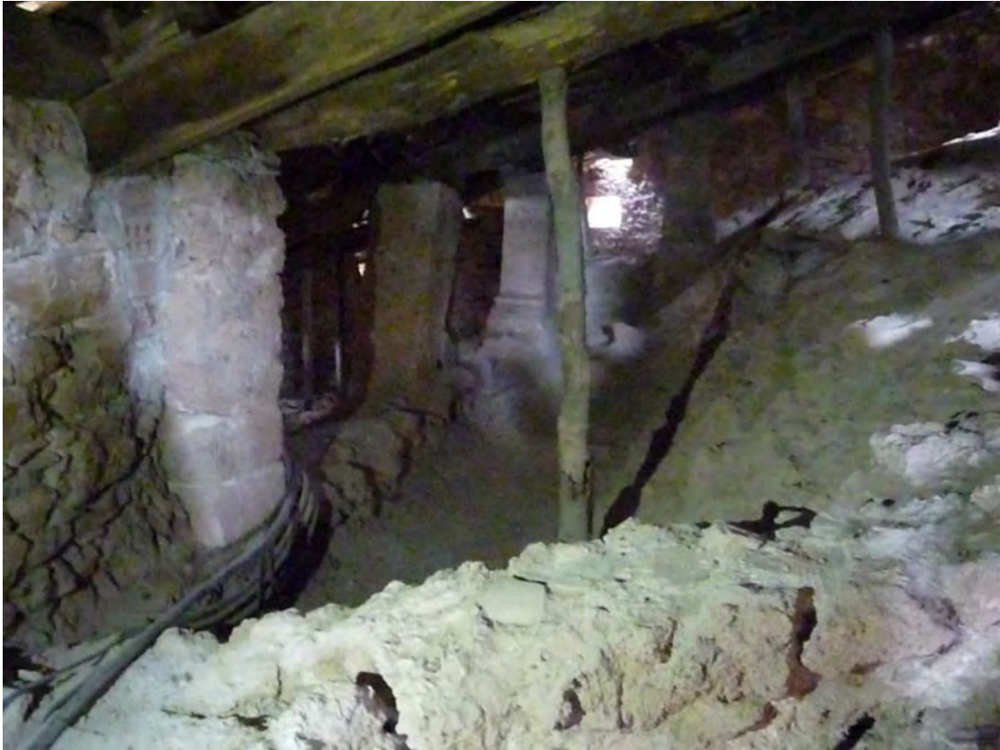
Intradós de la coberta, puntals d'obra de fàbrica i de fusta. Font B. Onecha, 2016
