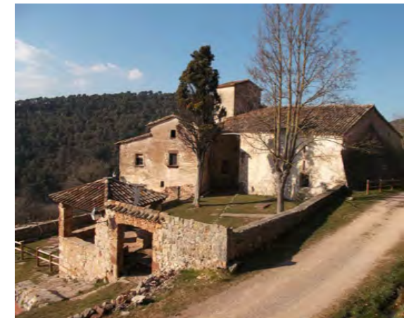
VISTA GENERAL SUD-EST
