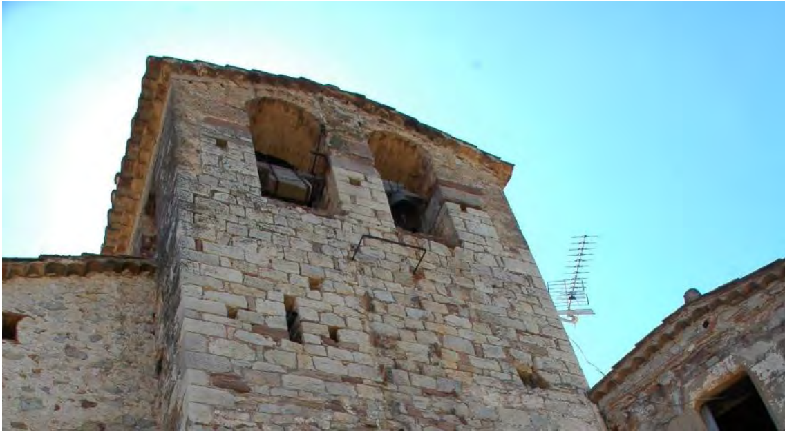
Extrems coberta campanar. Font B. Onecha, 2016
