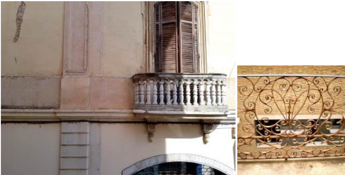
Façana a Avda Francesc Macià. Revestiment d'estuc de calç. Baranes de planta primera de balustres de pedra artificial. Baranes de la planta segona de ferro forjat.
