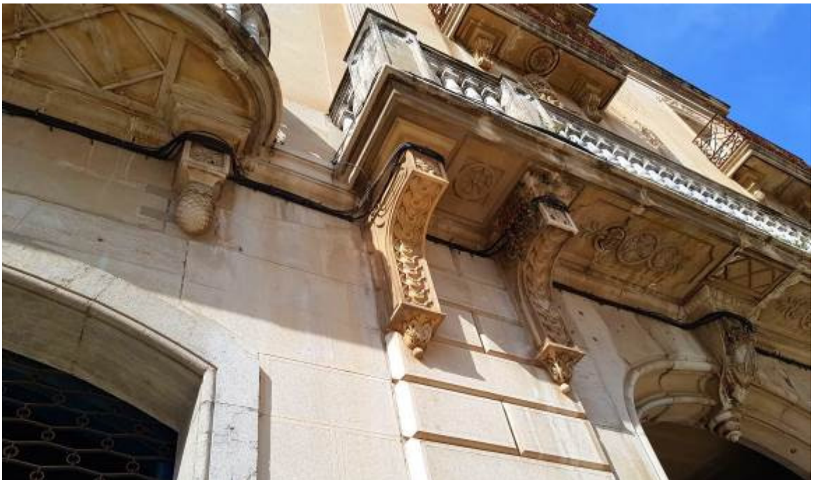
Façana principal, a la Plaça de la Vila. Brancals, mensules, llossanes i aplacats de pedra natural en cos central i en planta baixa i en balcons de planta segona.
