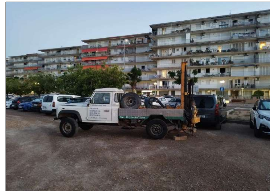
Emplaçament del penetròmetre P-2.
