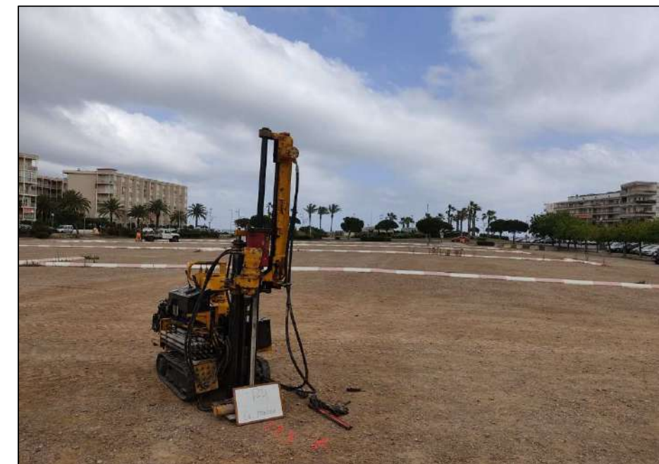
Emplaçament del penetròmetre P-3.
