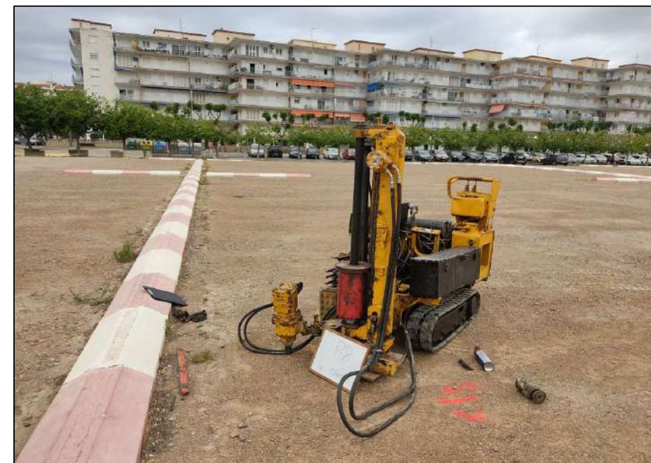
Emplaçament del penetròmetre P-8.
