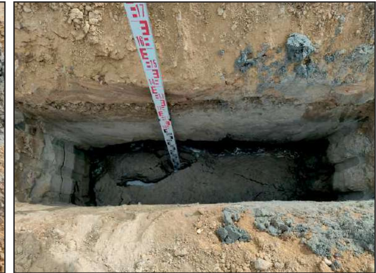
Vista del fons de la cala C-1.
