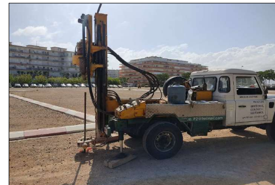
Emplaçament del penetròmetre P-1.
