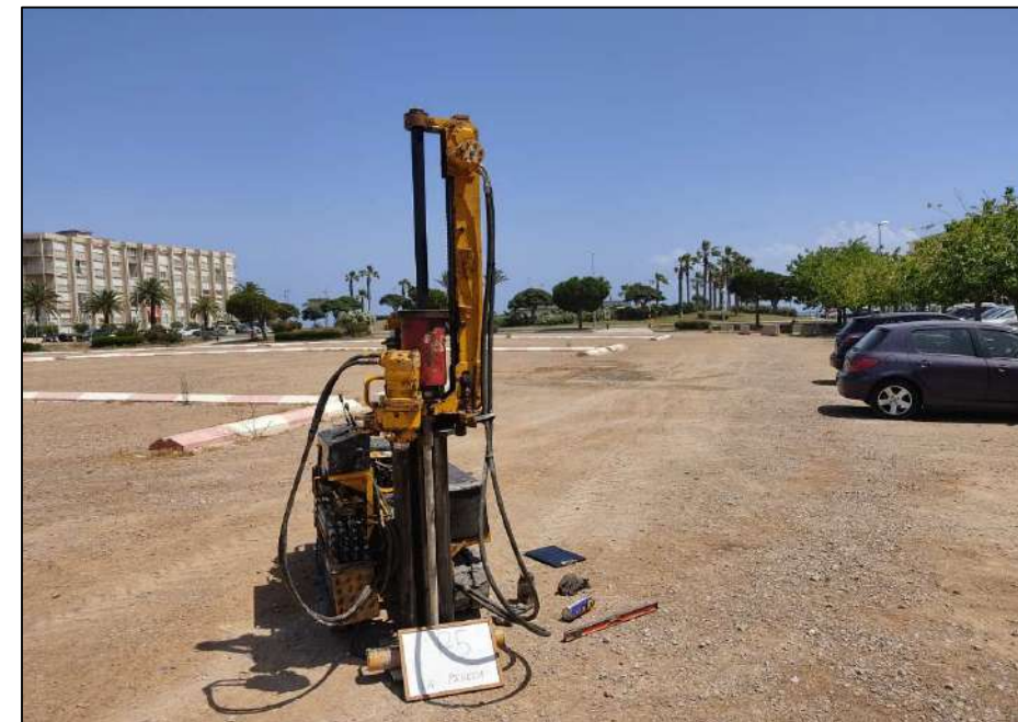
Emplaçament del penetròmetre P-5.
