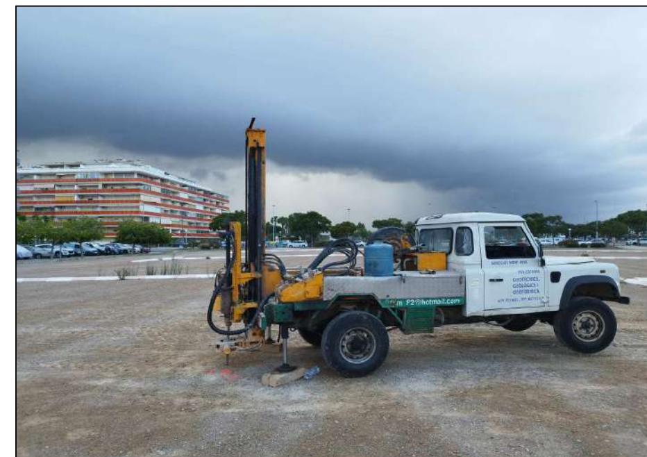
Emplaçament del penetròmetre P-6.
