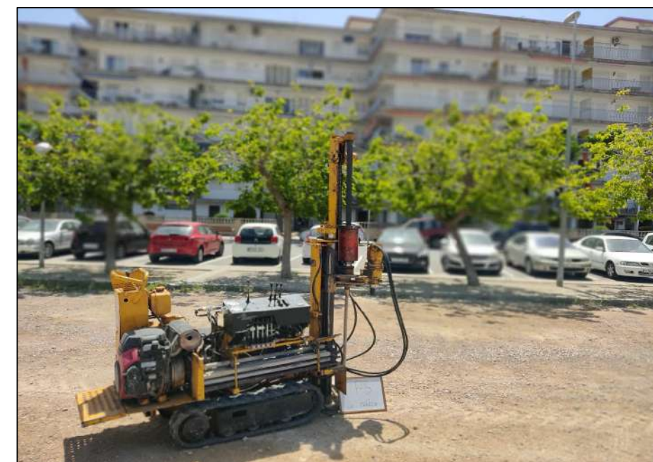
Emplaçament del penetròmetre P-5.
