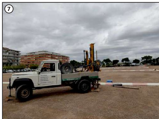
Vista desde l'extrem sud de la zona a construir amb el punt d'emplaçament del sondeig S-2.
