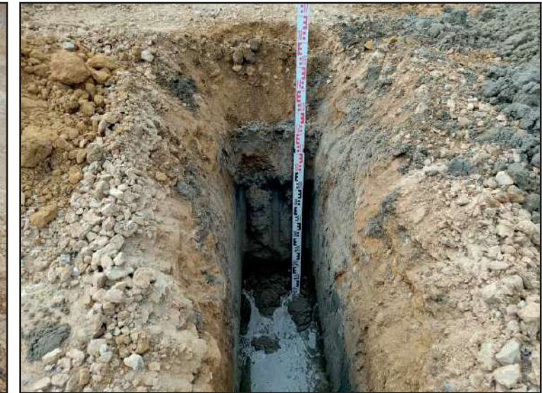
Vista del fons de la cala C-2.
