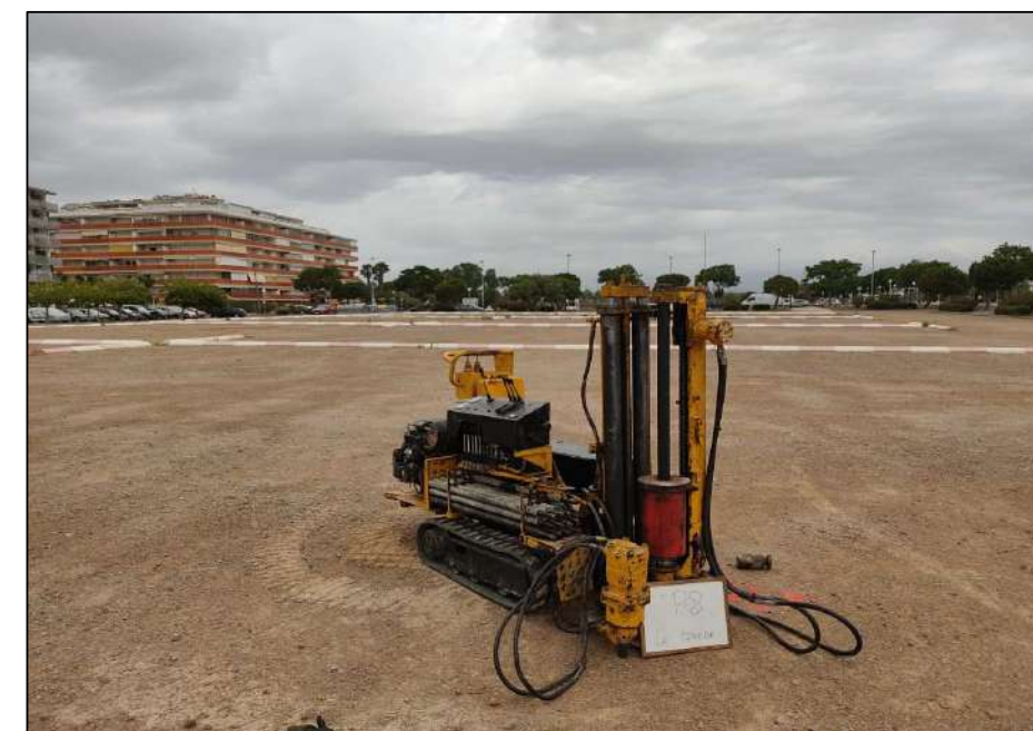
Emplaçament del penetròmetre P-8.
