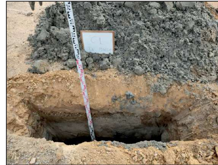
Vista general de la cala C-1.
