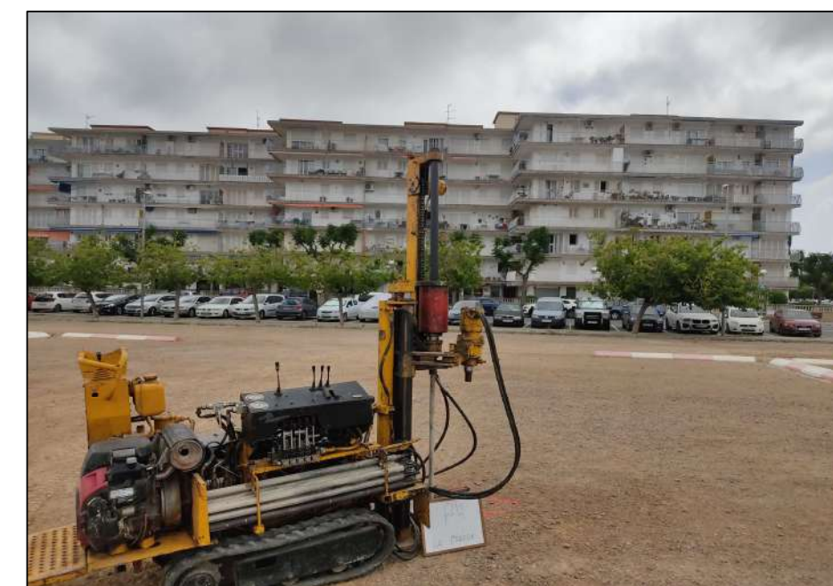
Emplaçament del penetròmetre P-3.
