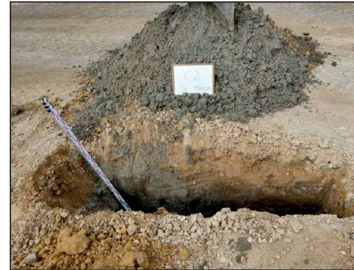
Vista general de la cala C-2.
