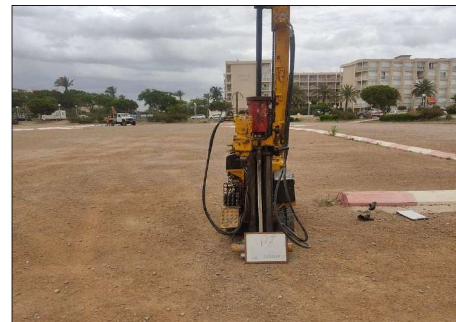
Emplaçament del penetròmetre P-7.
