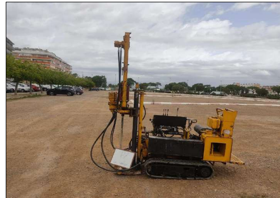
Emplaçament del penetròmetre P-7.
