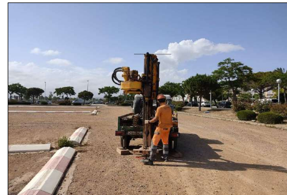
Emplaçament del penetròmetre P-1.
