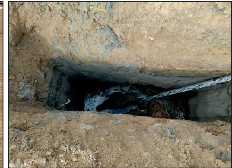
Vista del fons de la cala C-3.
