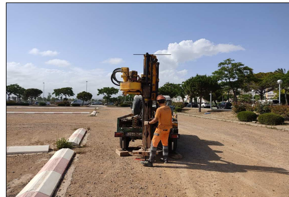
Emplaçament del penetròmetre P-1.
