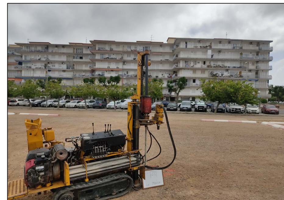
Emplaçament del penetròmetre P-3.
