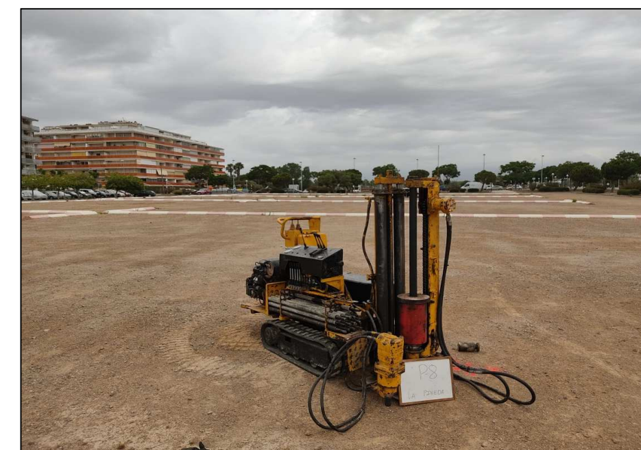
Emplaçament del penetròmetre P-8.
