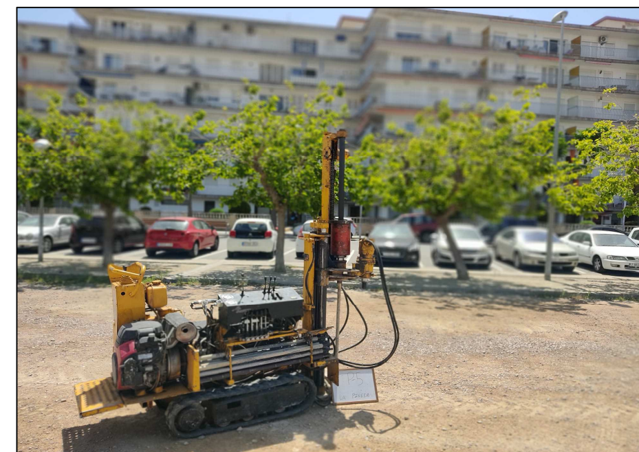
Emplaçament del penetròmetre P-5.
