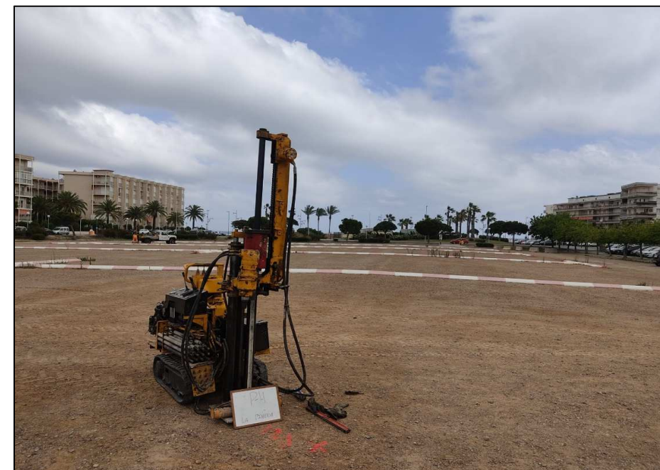
Emplaçament del penetròmetre P-4.
