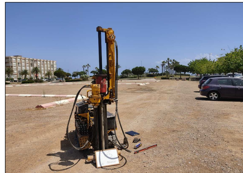
Emplaçament del penetròmetre P-5.
