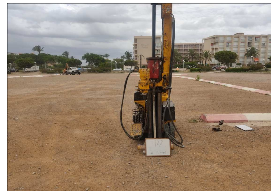
Emplaçament del penetròmetre P-7.
