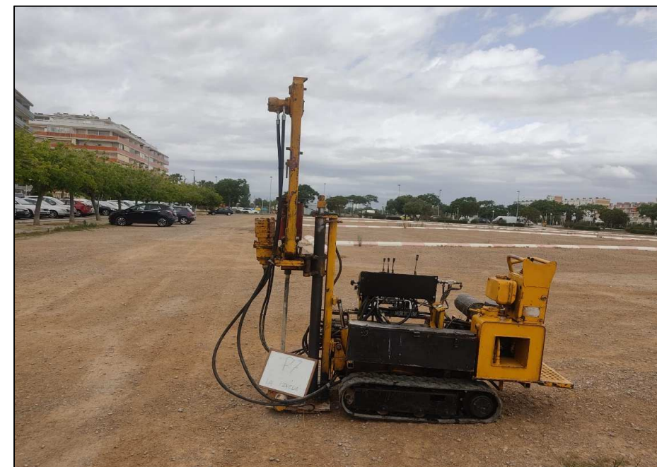
Emplaçament del penetròmetre P-7.
