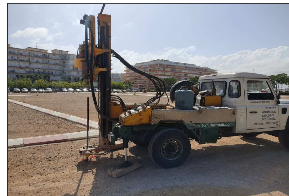
Emplaçament del penetròmetre P-1.
