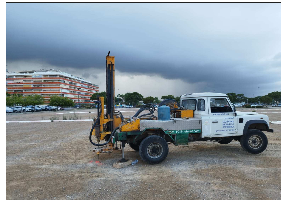
Emplaçament del penetròmetre P-6.
