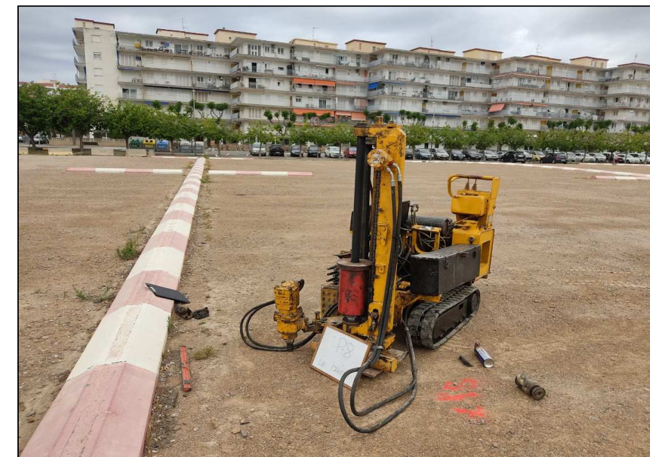
Emplaçament del penetròmetre P-8.
