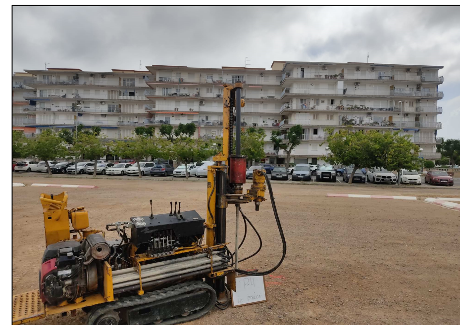
Emplaçament del penetròmetre P-4.
