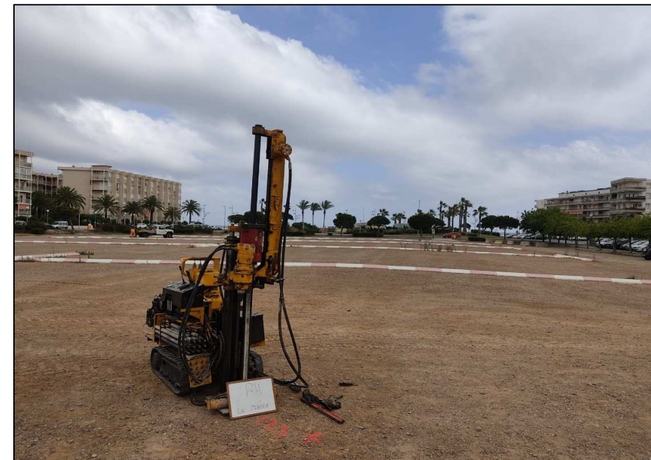
Emplaçament del penetròmetre P-3.
