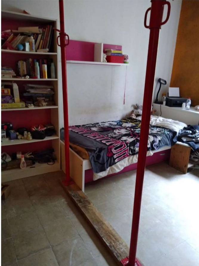
Sostre apuntalat en dormitori escala “C”
