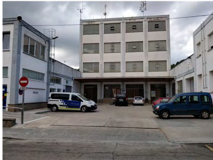
PLAÇA D'ACCÉS L'ANTIGA FÀBRICA SANAHUJA
