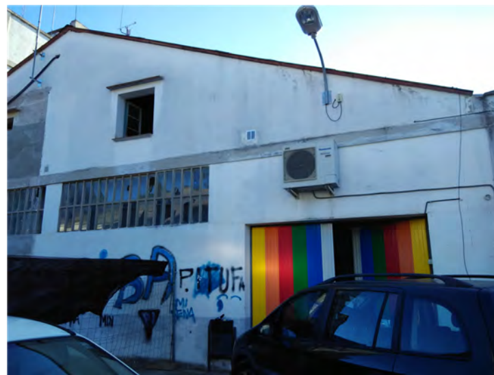
PORTA ACCÉS ESPAI CREU ROJA. FAÇANA NORD OEST
