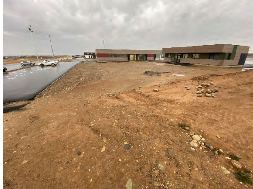
Imatge 4: Edificis i aparcament existents.
