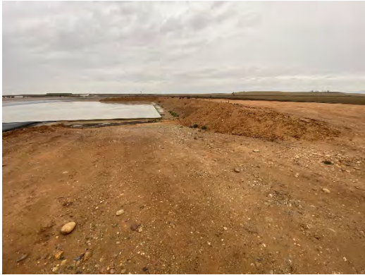
Imatge 3: Terreny a rebaixar contigu a la llosa existent.
