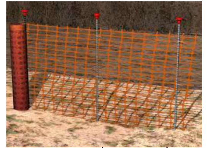
MALLA PROTECCIÓ EXCAVACIÓ
