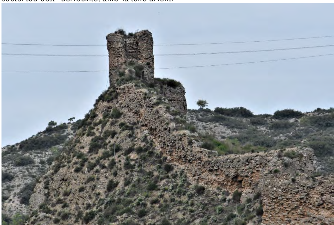
Projecte de consolidació i restauració de la muralla sud-oest del castell de Castellfolit de Riubregós
