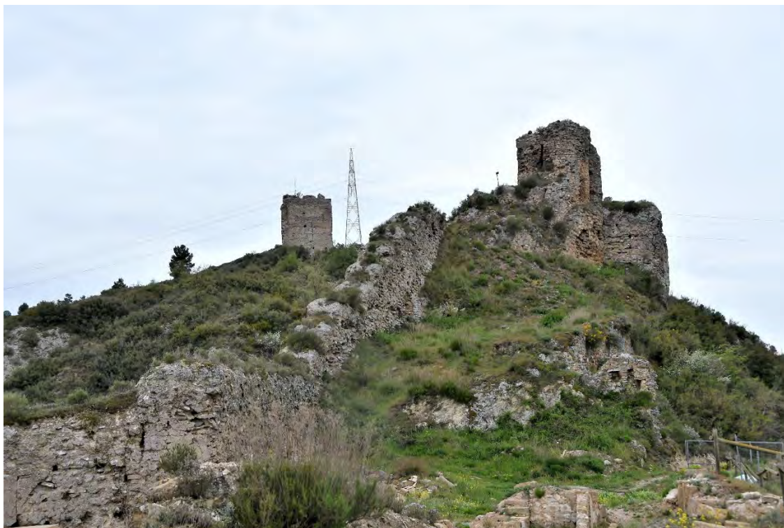
Cara interna del mur sud.
