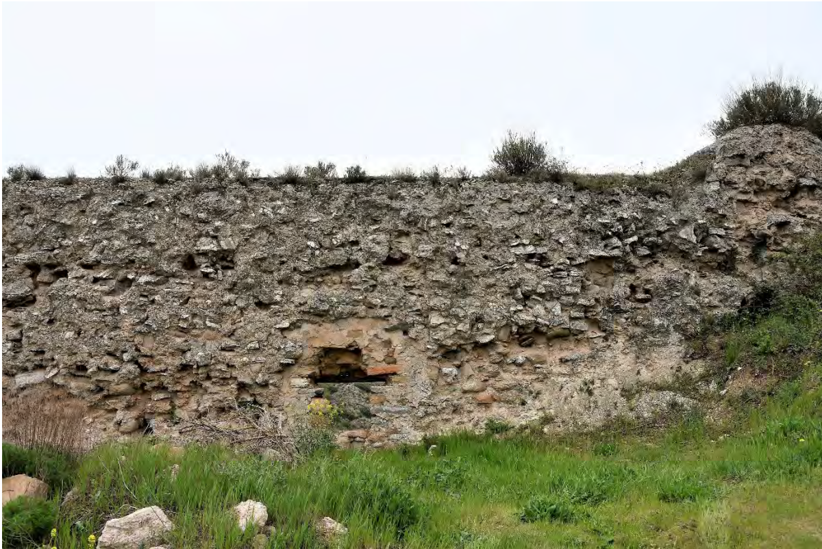
Detalls de la cara interna del mur sud, amb el parament amb carreus de pedra guixosa i formigó de guix, i el característic perfil graonat.
