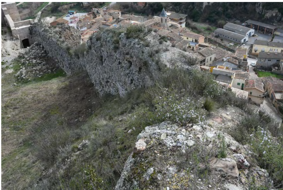
Detall de la coronació del mur sud.
