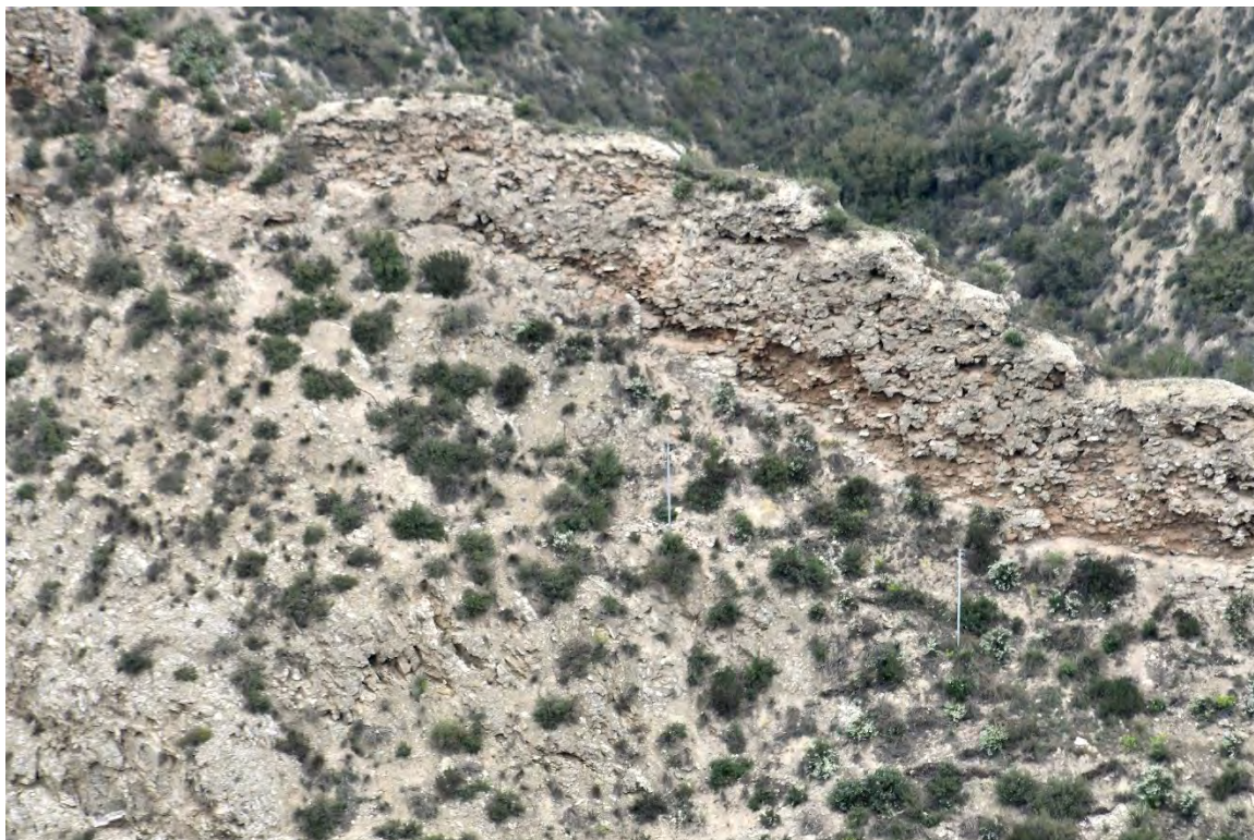
Detalls de la cara externa del mur sud, amb el parament molt afectat per les accions bèl·liques del Segle XIX
