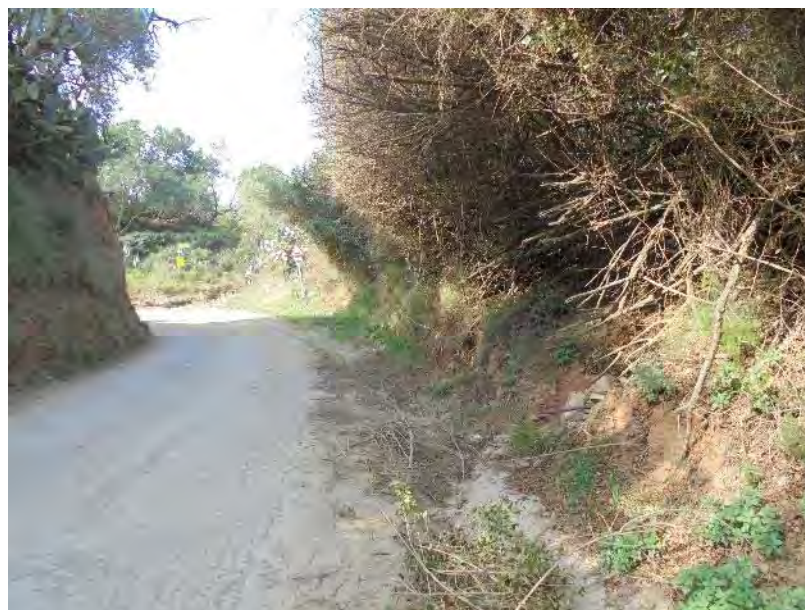
Cuneta del camí de la Selva tram costat marge esquerre
