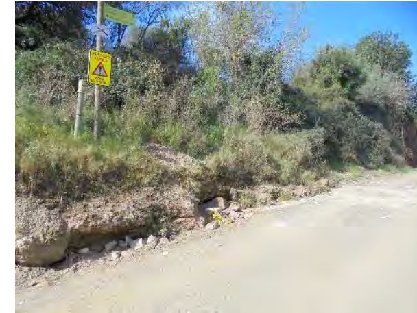
Foto esquerra erosions marge dret provocades per la cuneta, foto dreta erosions llera al marge esquerre
