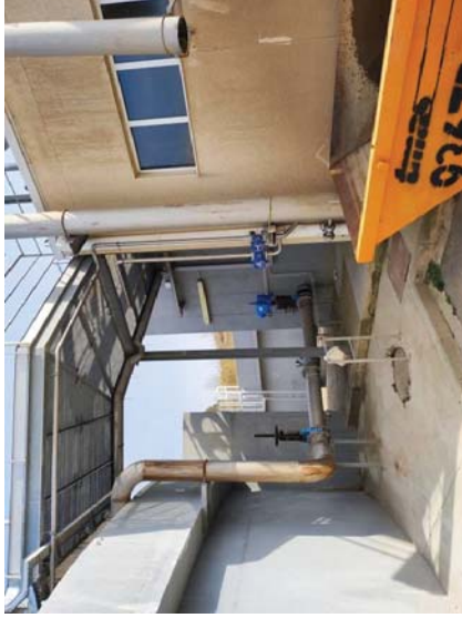
Figura 16. Traçat de canonada de la purga de fangs
