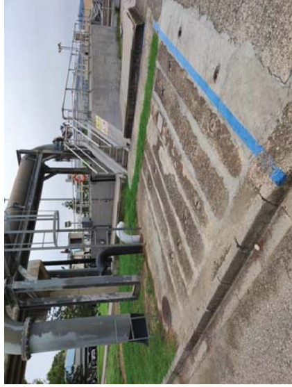
Figura 2. Arqueta vàlvula DN 1600 a substituir.
