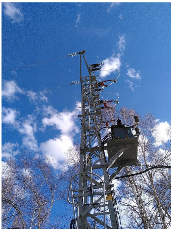
Figura 1: Detall del suport PT de final de línia de MT actual.
