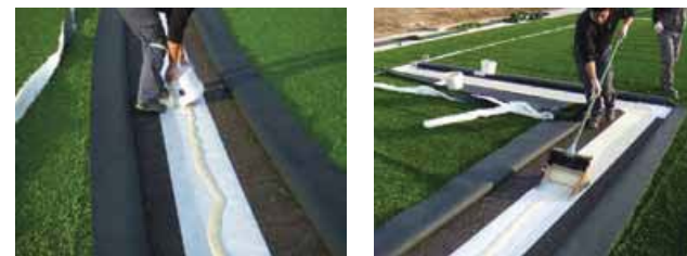
Figura 1. Pegado de una junta de unión de una pista de pádel de césped artificial
