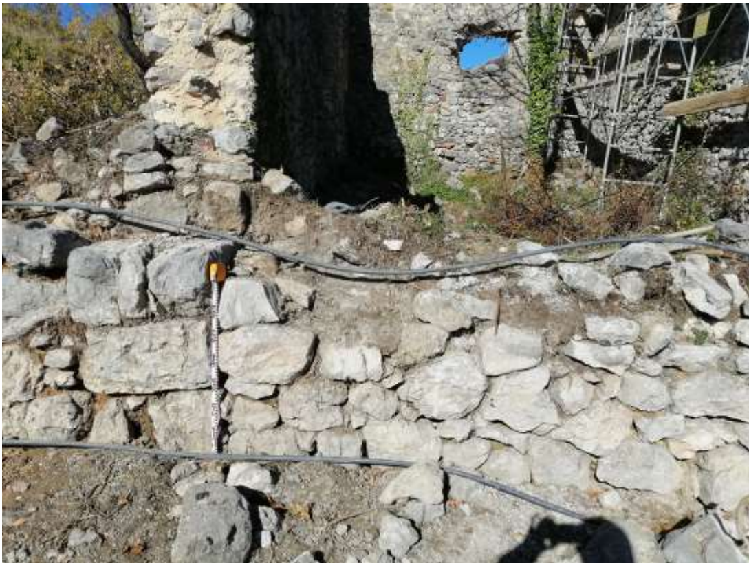
Parament d'una casa del carrer
