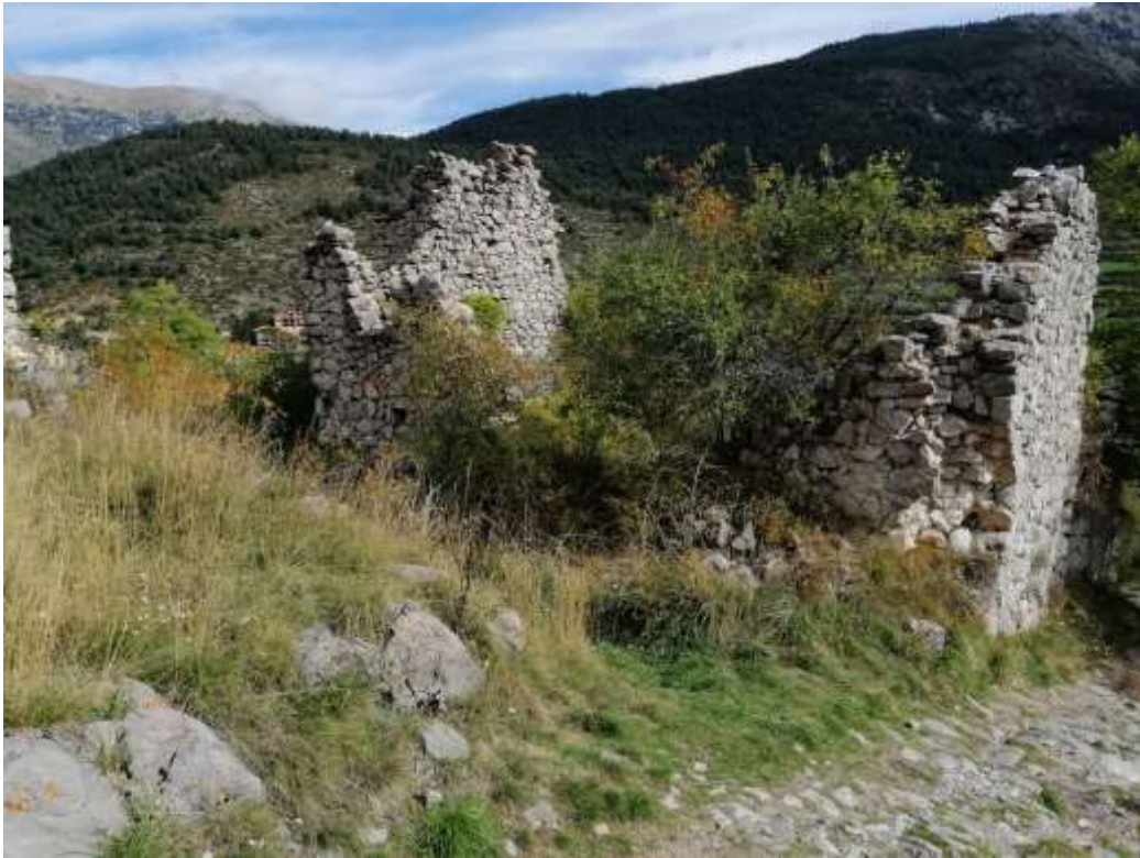
Estat incial del carrer
