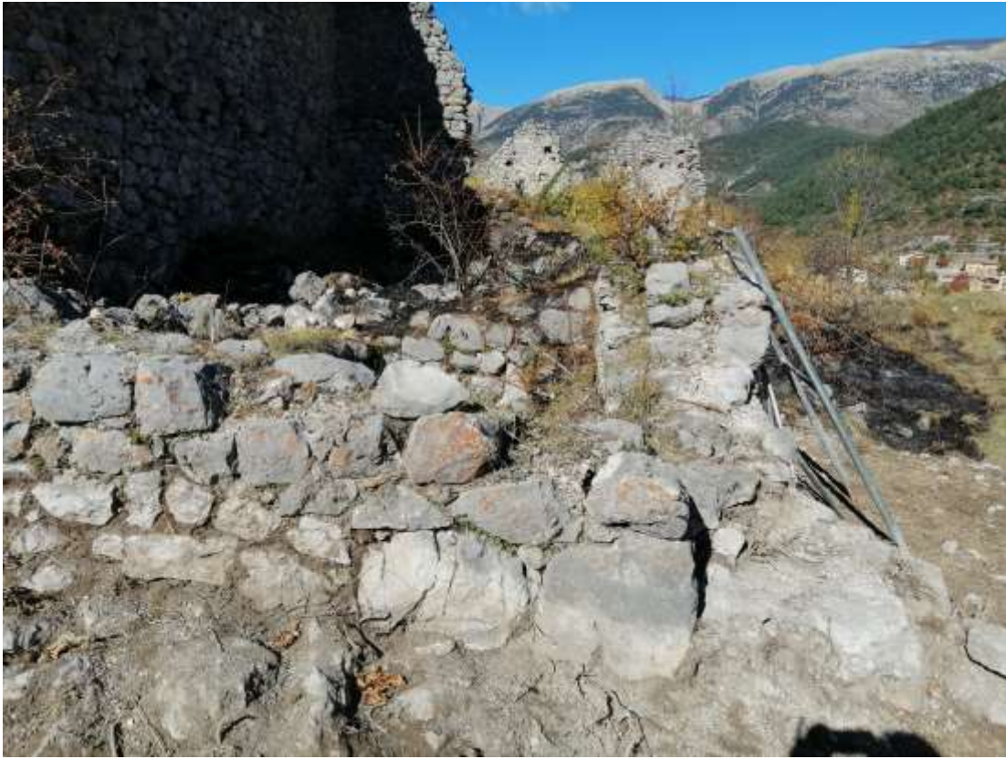
Detall dels murs d'una casa amb cisterna
