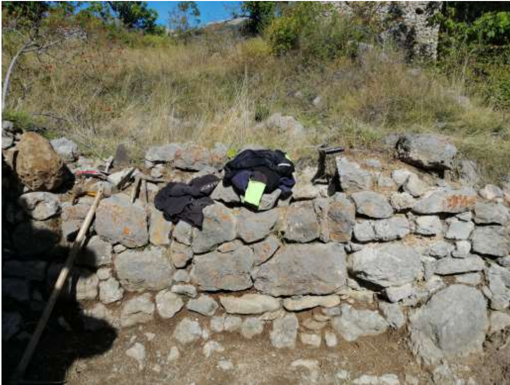
Una de les cases recuperades amb l'obertura d'accés
