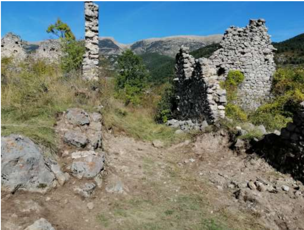
General d'un dels carrers que hi doba accés
