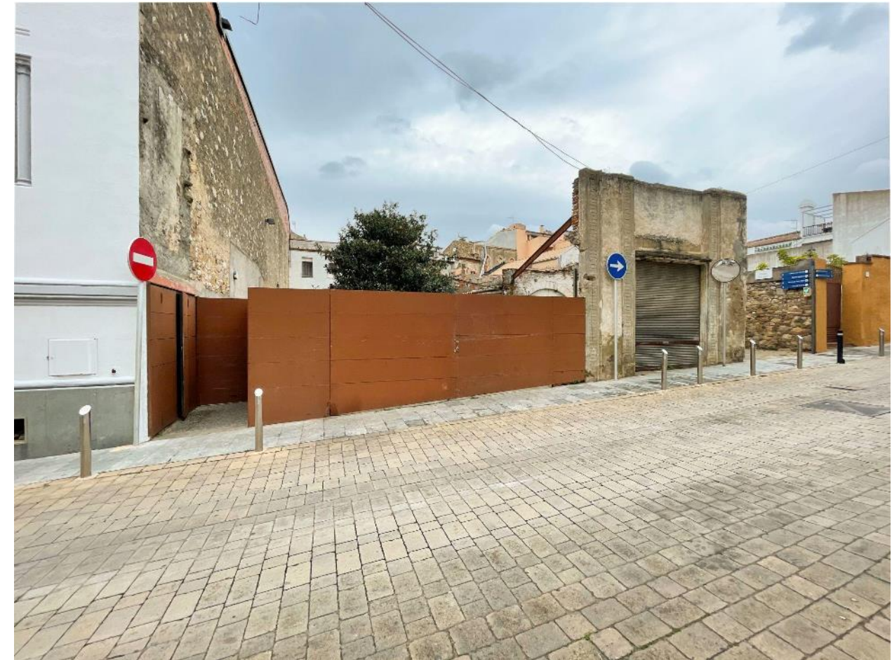
▲ Foto 2: Façana pati Saló Fontova, accés al pati
