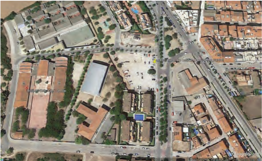
1 Situación del cuadro eléctrico
