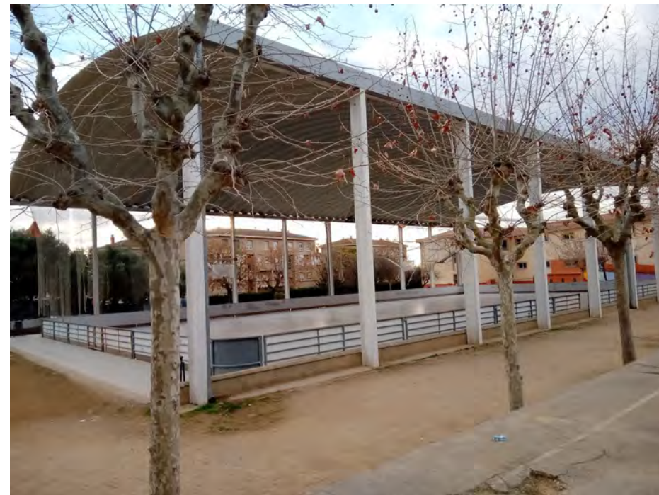
Pista esportiva a remodelar
