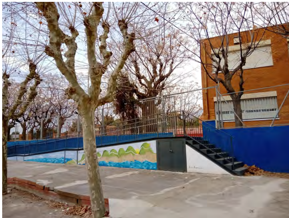
Rampa i escales a demoldre
