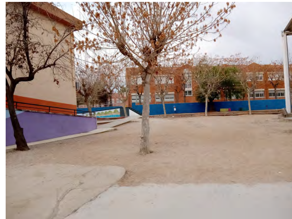
Mur a enderrocar
