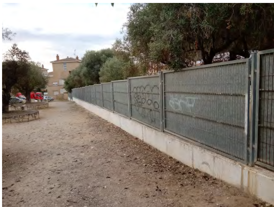
Mur de separació de les instal·lacions i l'aparcament des de l'exterior
