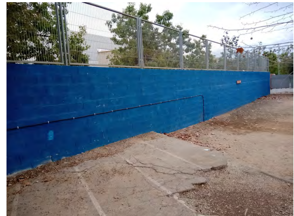
Mur de separació amb el carrer Joan Nin vist des de l'interior de les instal·lacions
