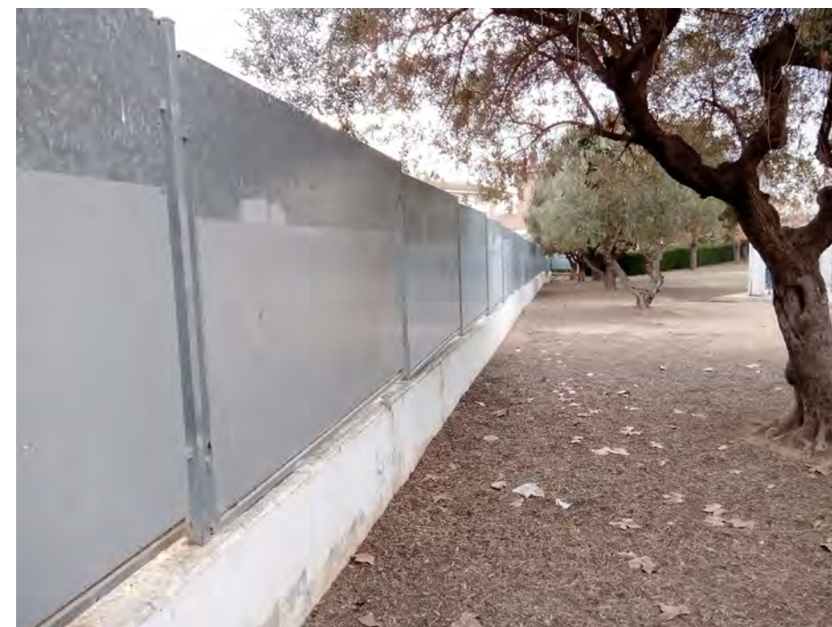
Mur de separació entre instal·lacions de l'institut i aparcament, vist de l'interior de les instal·lacions
