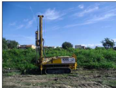
Foto-3: Vista parcial de la zona a edificar. Ubicació de l'assaig DPSH-3.
