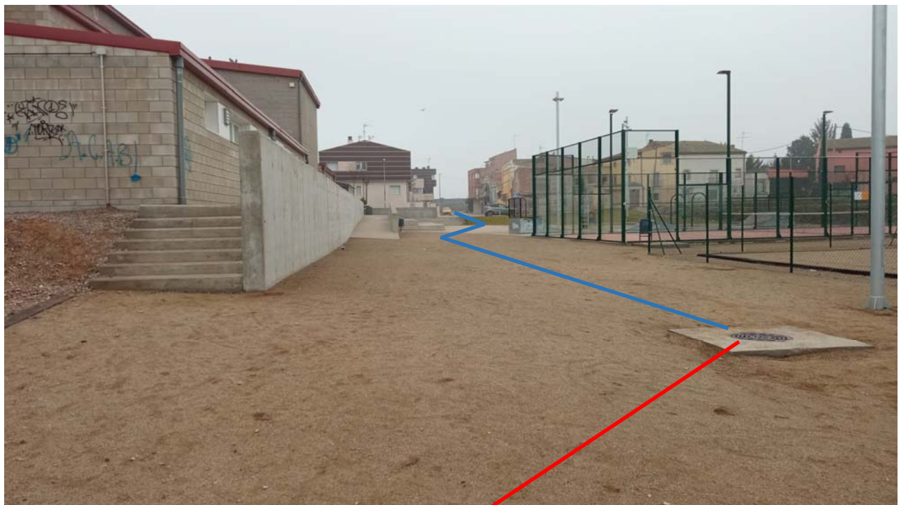
Fotografia 6. Cantonada nord-oest poliesportiu (pK 586m.) - Direcció sud Arqueta de connexió amb col·lector existent
