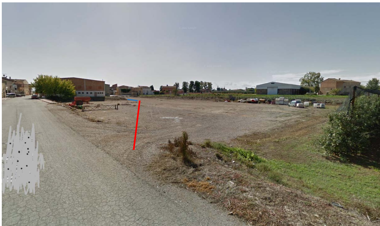
Fotografia 7. Entrega al col·lector de camí de Linyola (pK 669) - Direcció nord Final obra
