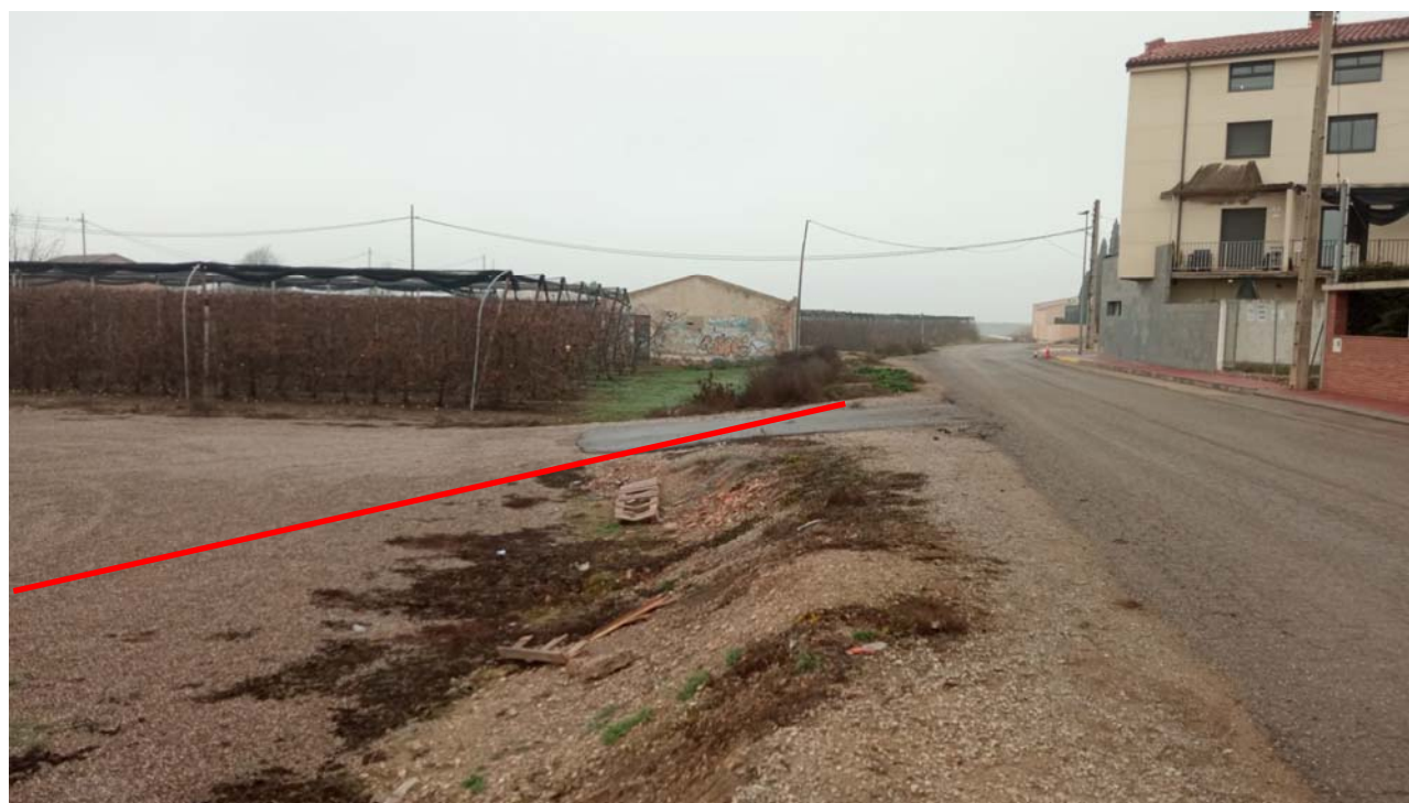
Fotografia 8. Entrega al col·lector de camí de Linyola (pK 669) - Direcció nord Final obra
