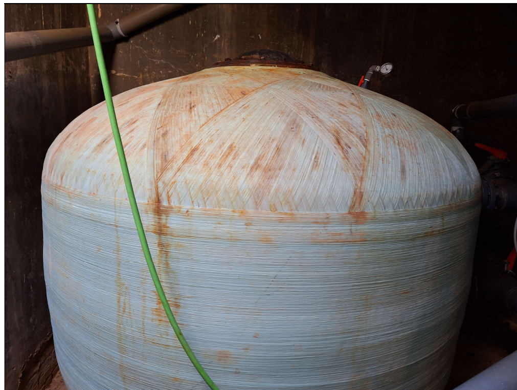
Figura núm. 8 Caseta d'instal·lacions. Estat actual filtre
